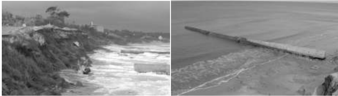
Figura 9.- Vista desde el Oeste de los espigones 7 y 8 (izquierda) y descenso de la playa evidenciado en el espigón 7 (derecha)
