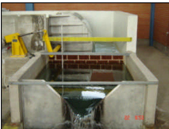
Figura 3.4.- Vertedero de cresta delgada ubicado al final del canal
