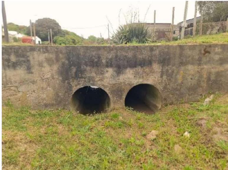
Figura 4.2. Alcantarilla a rediseñar. Imagen tomada en visita a campo.
