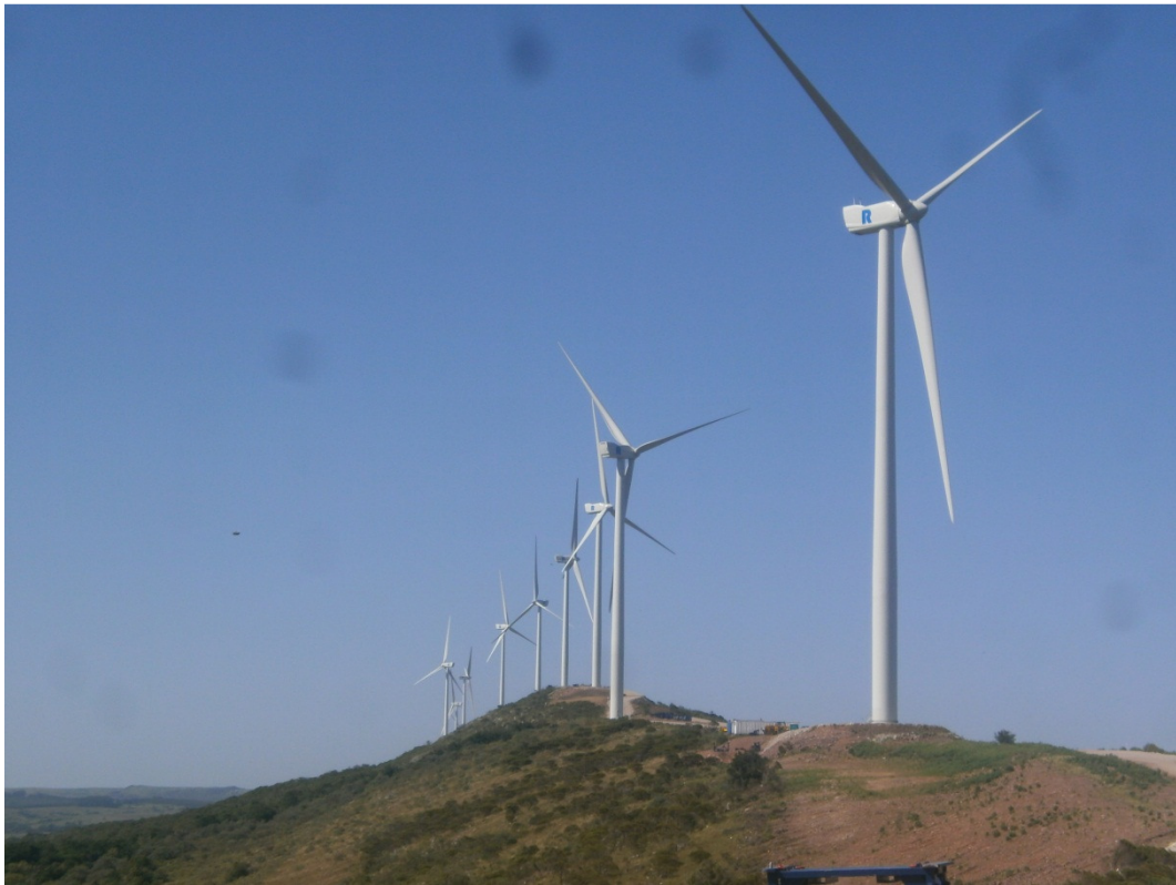
Figura 1.5: Parque eólico R del Sur (foto cortesía R del Sur)
