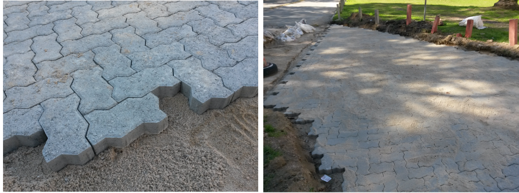
(a) Adoquines colocados sobre cama de arena. (b) Adoquines con arena en su superficie para el relleno de la junta.
