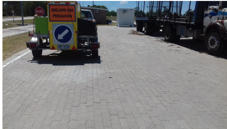
(b) Pavimento en acceso a balanza en Ruta N°8.
