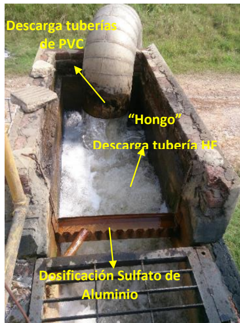
Figura 2.5. Zona de Mezcla del coagulante.
