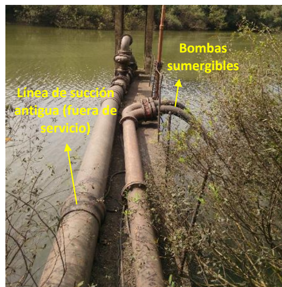
Figura 2.3. Succión de agua bruta hacia la UPA 2000.
