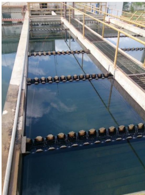
Figura 8.11 Sedimentador de Flujo Laminar
