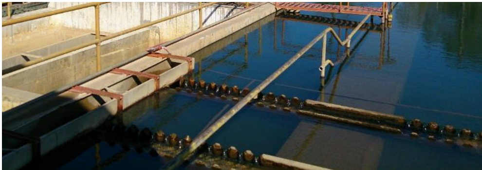
Figura 8.9 Salida del Sedimentador Horizontal
