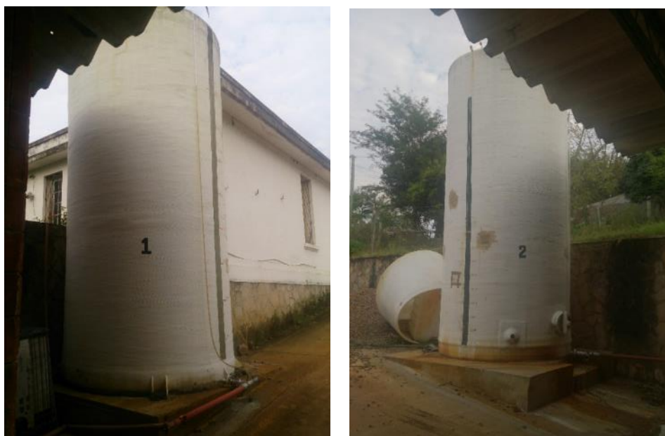
Figura 2.8. Tanques de almacenamiento del Sulfato de Aluminio.
