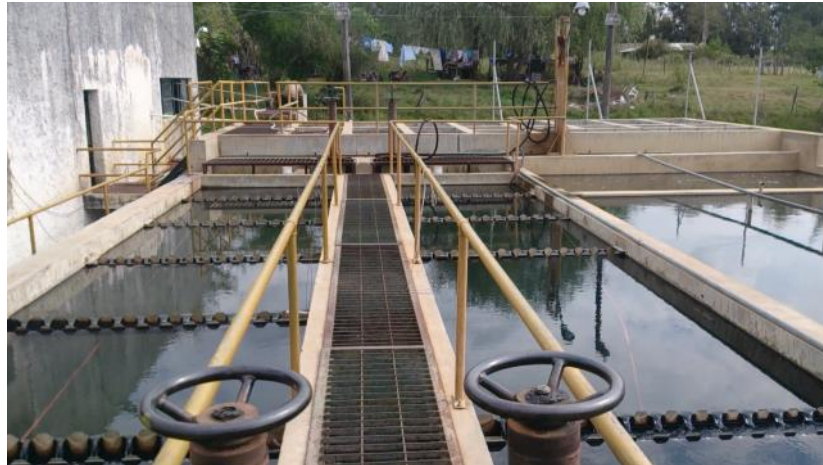
Figura 2.13. Sedimentador de Placas Planas Paralelas.
