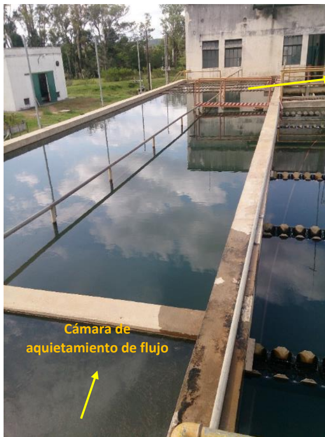
Figura 2.12. Sedimentador convencional de flujo horizontal
