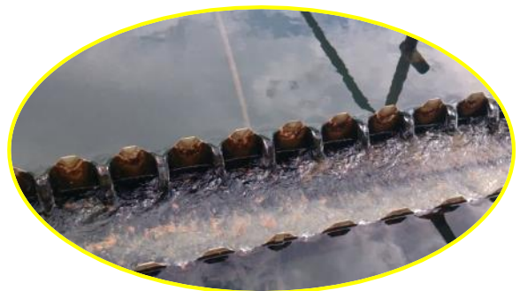
Figura 2.11. Detalle canaleta de recolección de agua con vertederos triangulares
