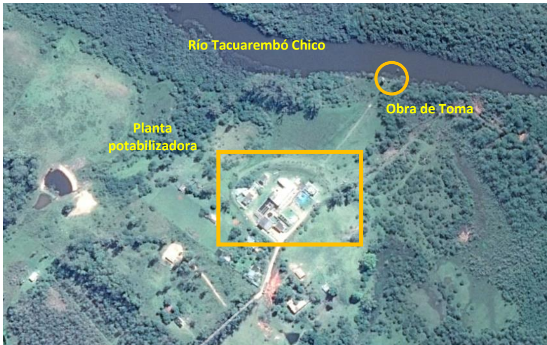
Figura 2.1 Planta Potabilizadora de Tacuarembó (imagen: Google Earth)
