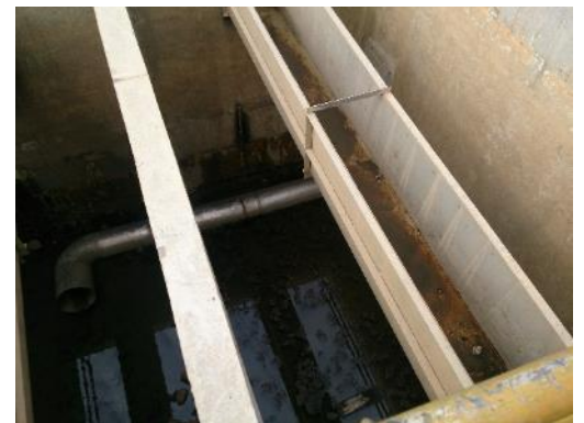
Figura 2.16. Filtro exterior fuera de Servicio.
