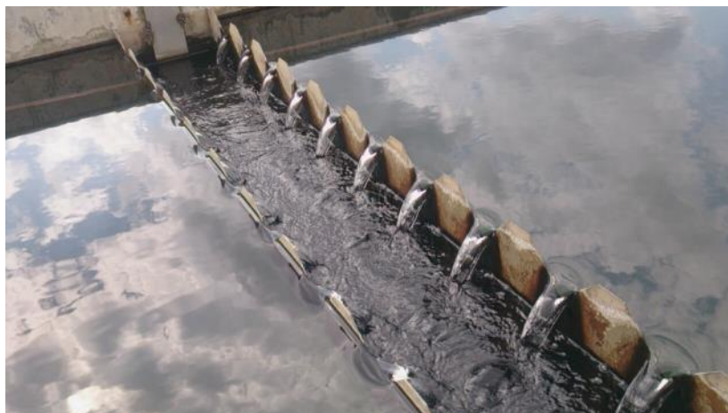
Figura 8.10 Canaleta de recolección de agua para Sedimentador Convencional
