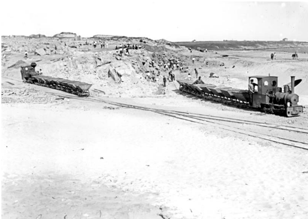
Fig. 8.10 Construcción de la rambla de Malvín. Al fondo, a la derecha se ve Punta Gorda, 1918.
