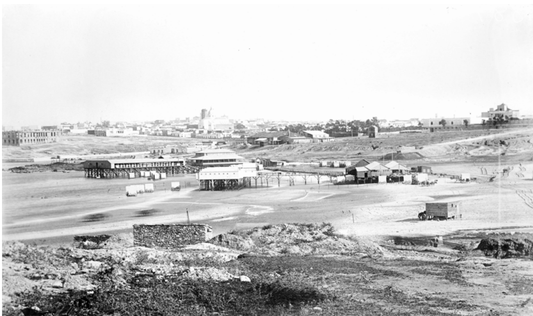
Fig. 7.29a Vista general hacia el oeste de las instalaciones reconstruidas y ampliadas, 1895.
