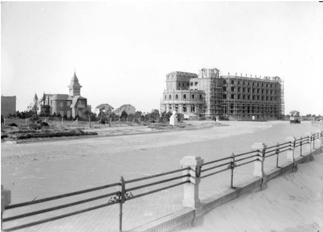
Fig. 7.48 La Rambla de Carrasco pavimentada. El Hotel Carrasco todavía en construcción.
