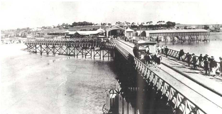
Fig. 7.32 Imagen del loop de regreso para los tranvías, apreciable sobre la izquierda de la fotografía, 1900.
