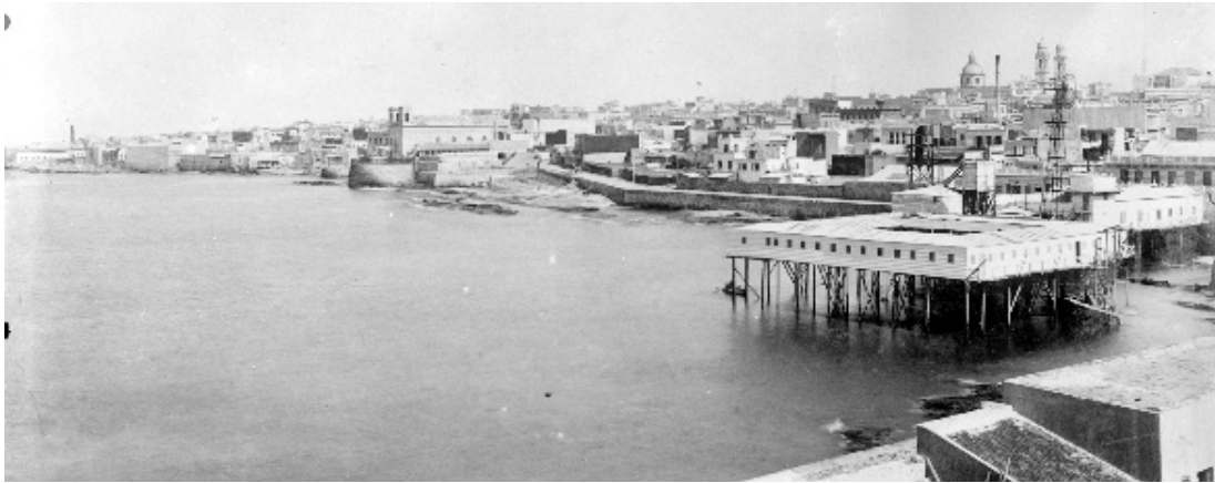
Fig. 7.22 Instalaciones de los Baños de Aurqía en 1910. A la izquierda se ve el Templo Inglés, CDF.
