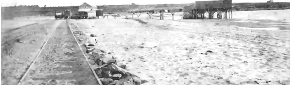
Fig. 7.28 Vista hacia el este de los baños de Hombres. Sobre la izquierda de la imagen las vías del tranvía, 1880.
