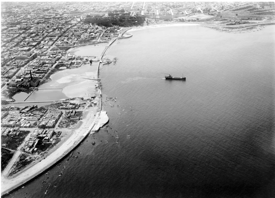
Fig. 7.16. La Rambla Sur en construcción. Se aprecia como el trazado le gana tierra al río en algunas zonas y anula las playas de Santa Ana e Isidoro, CDF.
