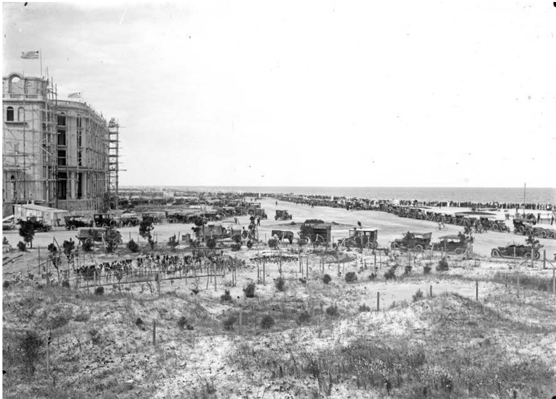
Fig. 7.46 El Hotel Carrasco en construcción. La Rambla de Carrasco ya contaba su característica baranda, 1912.
