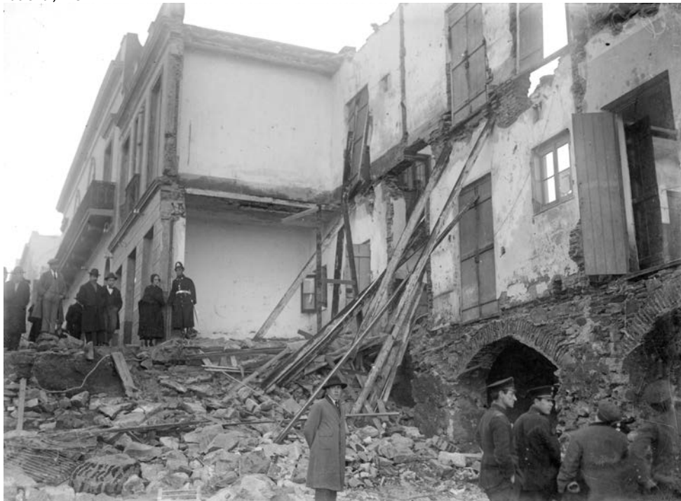
Fig. 7.13 Temporal del año 1923, el estado en que quedaron las construcciones del "Bajo", CDF.
