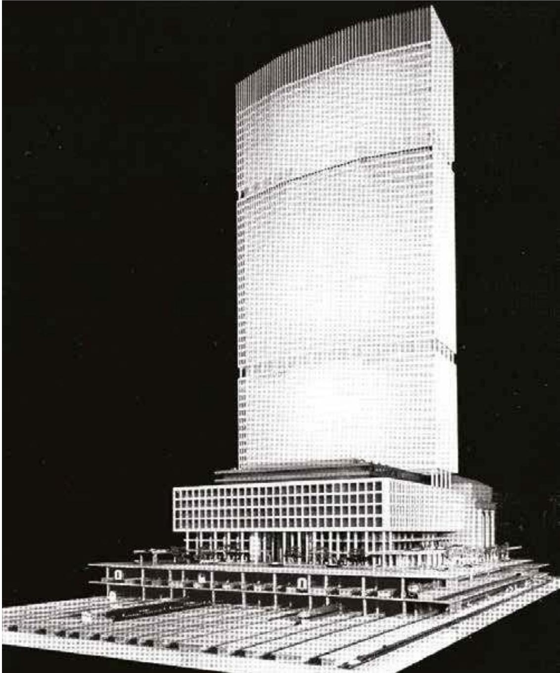
Fig. 5.13 Maqueta del *Pan Am Building* (Pietro Belluschi, Emery Roth & Sons, Walter Gropius). El edificio se acopla al sistema. Se pueden observar los distintos niveles de tránsito diferenciados coordinados con la nueva estructura de la torre.
