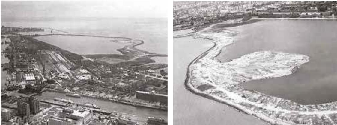
Fig. 4.8 Vista aérea de los terraplenes perimetrales del ensanche proyectado en el puerto, Buenos Aires, 1980.
