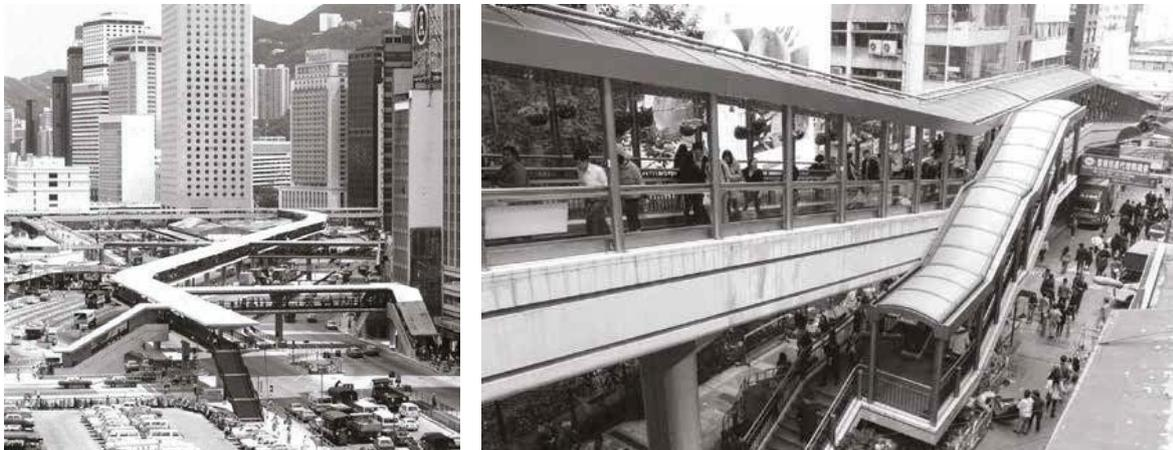
Fig. 5.44 Red de infraestructuras peatonales de Hong Kong en los años '80. Como una manga de aeropuerto, la cinta va conectando edificios, estacionamientos públicos y paradas del transporte público en *Connaught Road*, conector principal del área central. Fig. 5.45 Escalera mecánica exterior que vincula las áreas centrales con los barrios asentados en las laderas
