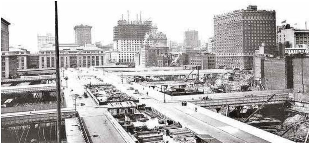
Fig. 5.10 *Park Avenue* y *Grand Central* en 1913. La grilla de calles y avenidas con las manzanas aún vacías dejan entrever las vías férreas en el nivel subterráneo. Al centro de la fotografía se aprecia otro edificio en construcción por detrás de una parte aún sin demoler de la vieja terminal.
