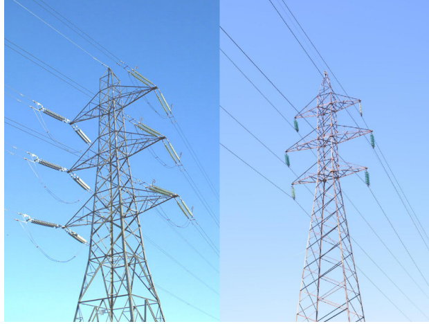
Figura 4.2: Torres de amarre (izquierda) y suspensión (derecha) típicas.
