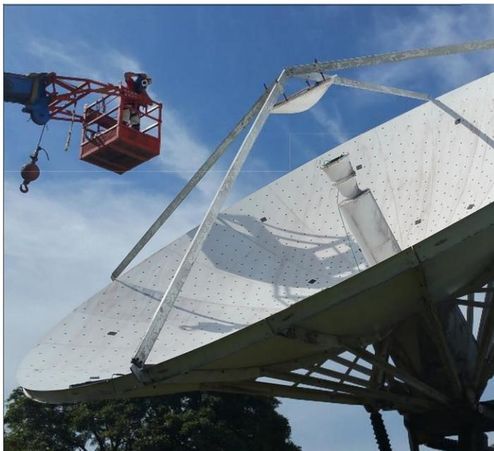
Figura 1.4: Obtención de imágenes para fotogrametría, realizada en la antena de 9m de la Universidad de Costa Rica. (Cortesía de David Gale, INAOE).
