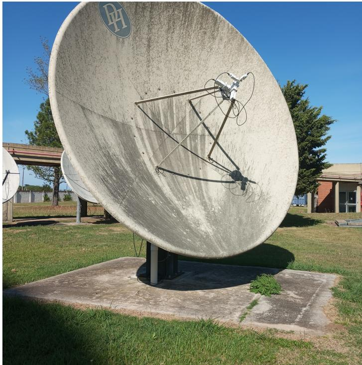
Figura 3.18: Antena de 4.5m y foco primario, con recepción en banda C y Ku.
