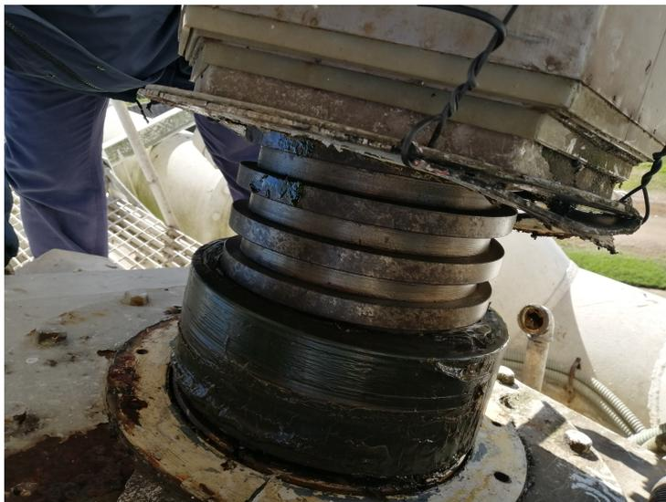
Figura 3.5: Desmontaje de vaina de protección del tornillo de elevación, para realizar el cambio de aceite.
