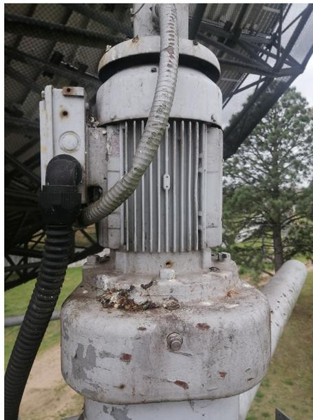
Figura 3.12: Motor de movimiento en acimut.
