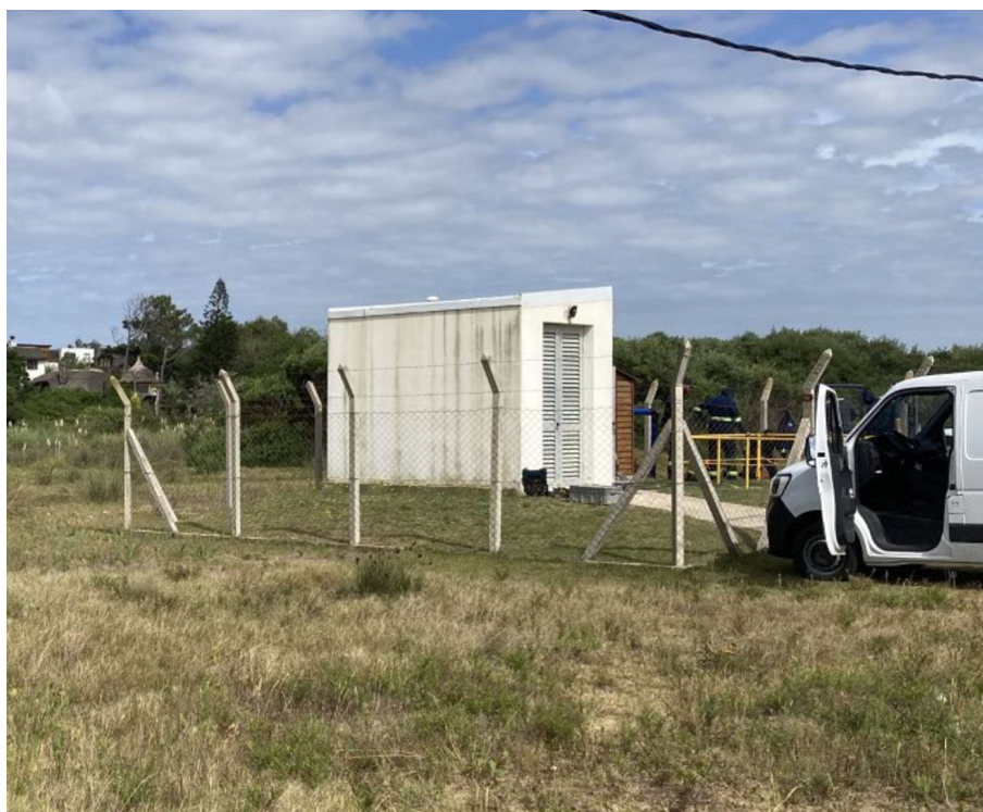
Figura 31: Estación de bombeo actual
