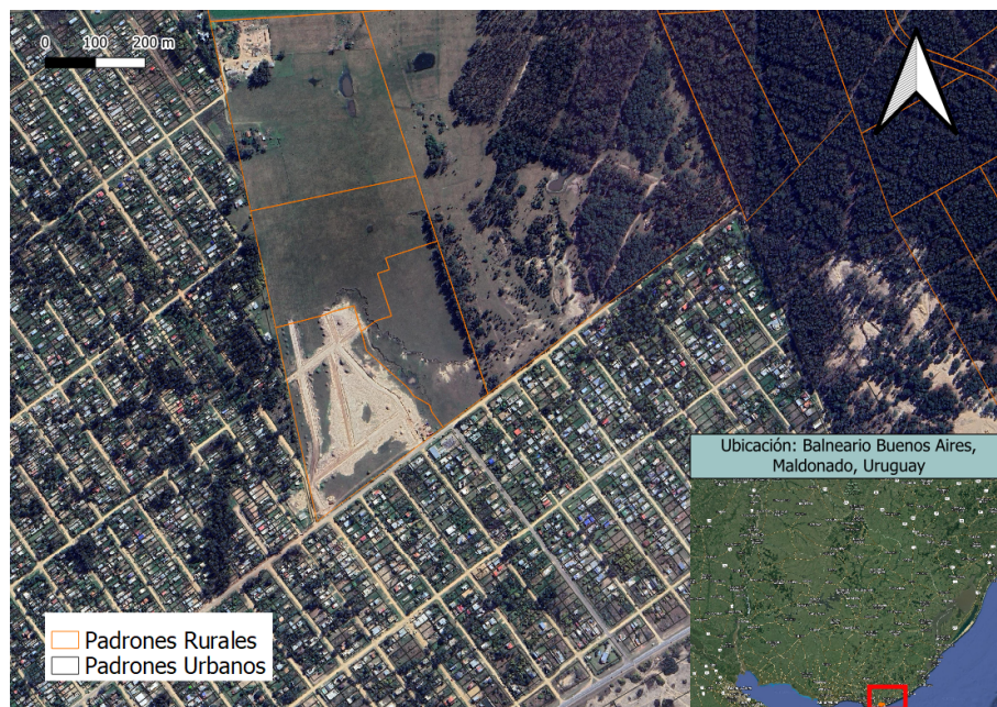
Figura 7: Calles en construcción sobre territorio suburbano
