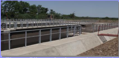
Figura: Piletas donde se deposita la vinaza en el ingenio azucarero para el futuro fertirriego. (Bella Unión)
