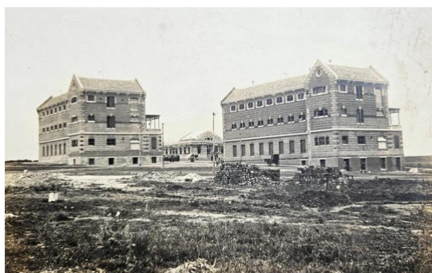
Figura 20. Colonia Educacional de Varones. Fachada longitudinal de los pabellones de asilados y foto del conjunto. Eduardo Porciúncula Salgado, «Gral. Arq. Alfredo R. Campos, Legado y Patrimonio», Boleín Histórico del Ejército , n.º 363 (2023): 29. Las fotografías pertenecen a una colección privada.
