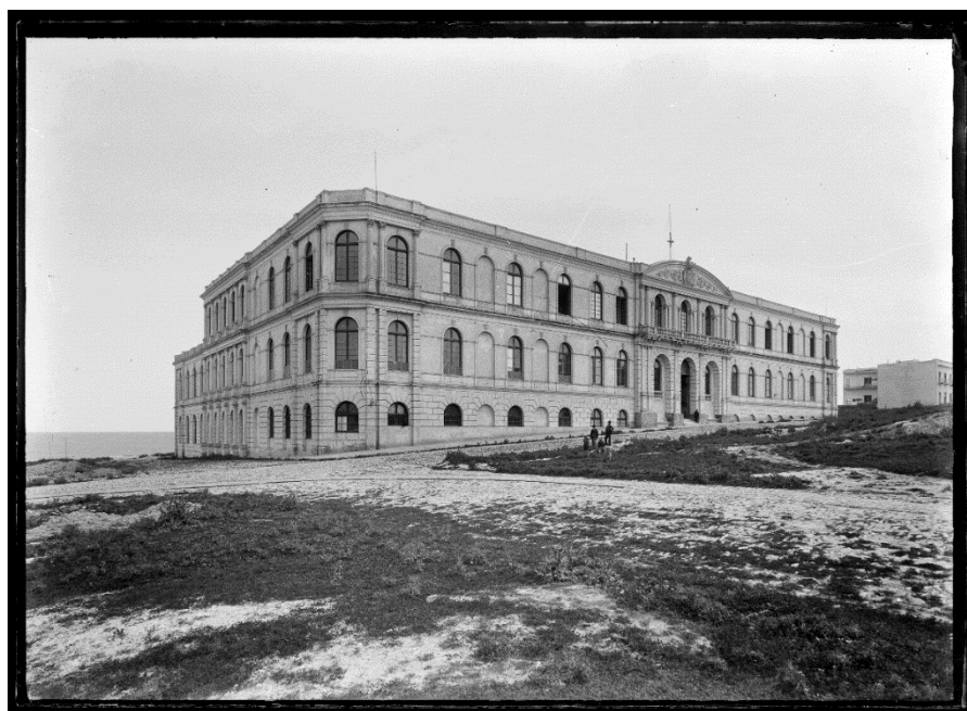
Figura 7. Edificio inaugurado en 1889, actual cede de la UTU ubicado en la calle San Salvador. Archivo CDF. 1890 1915- Código de referencia: 23358FMHGE
