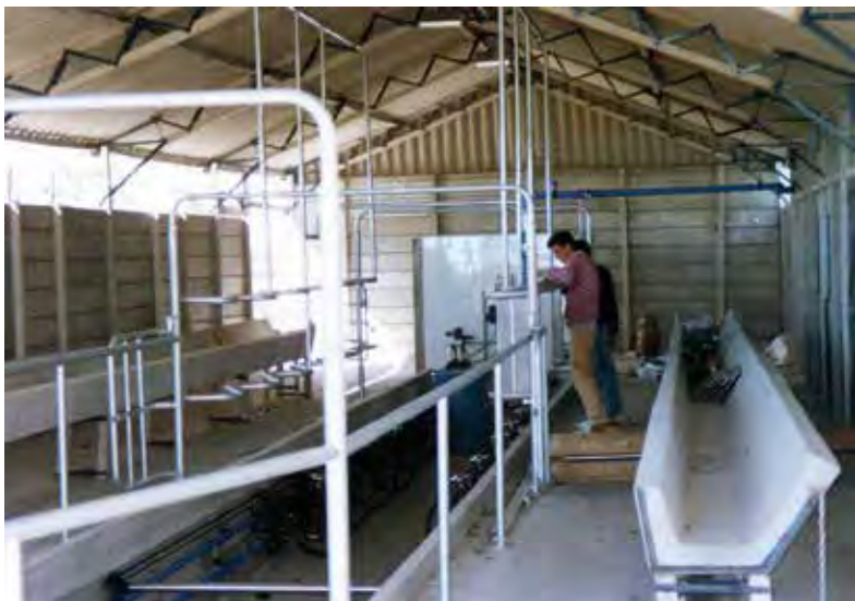
Otra vista de las obras en el tambo en 1996.
