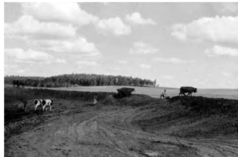
Reparando el tajamar en trabajo con bueyes. Fuente: José Krall.
