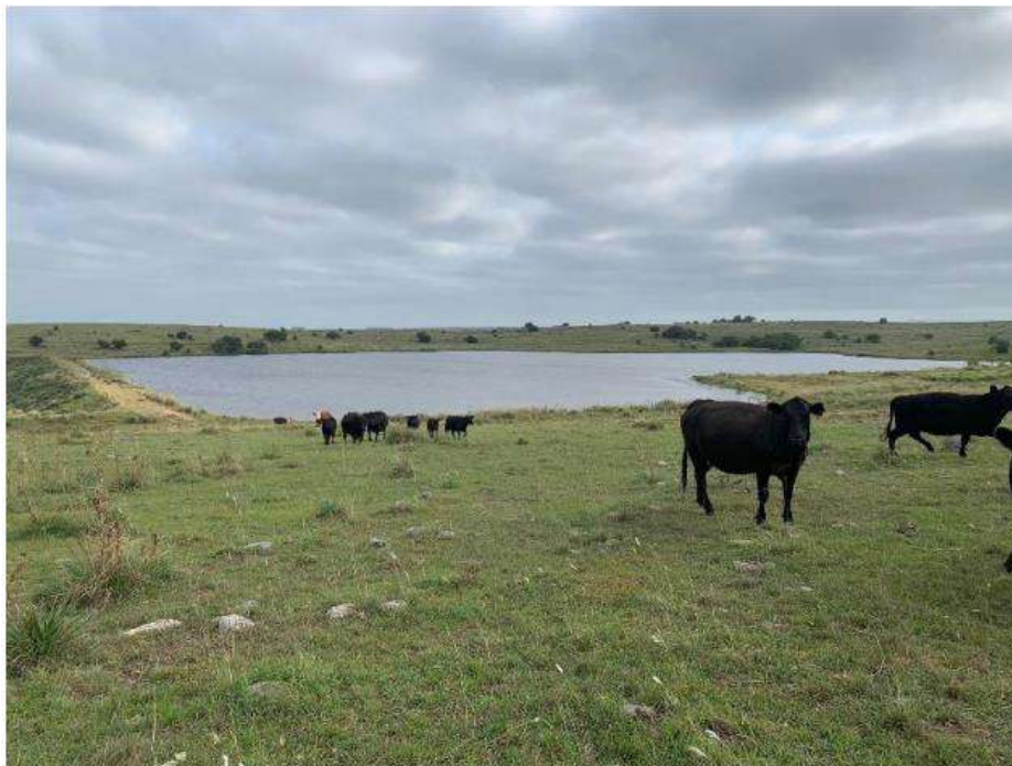
Figura 2-14: Vista del espejo de aguas de la represa existente.
