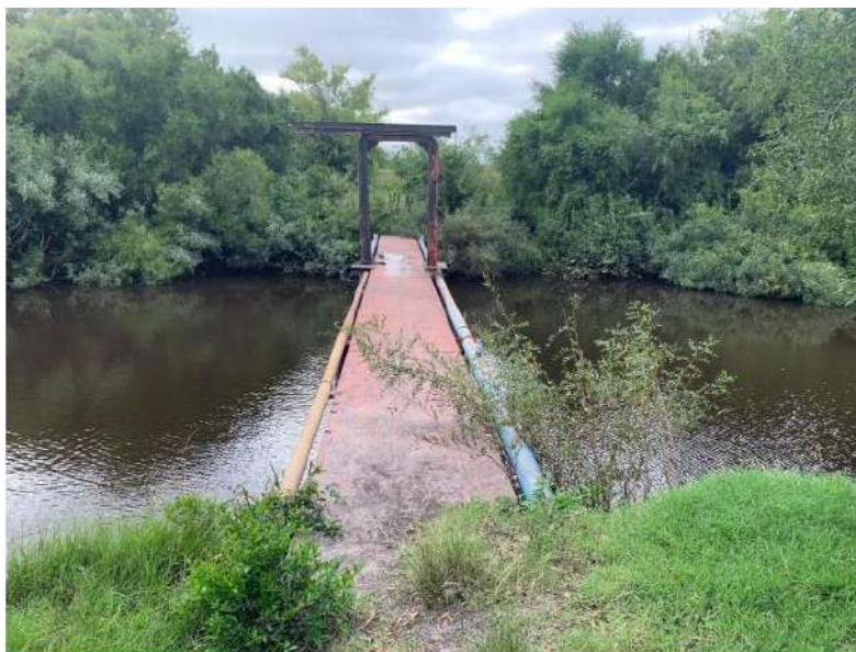
Figura 2-13: Puente metálico y conducciones de toma de extracción existente.
