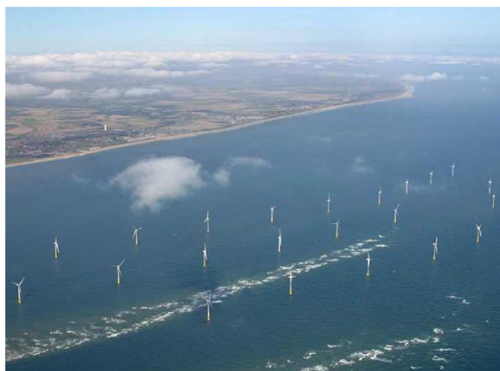
Figura 7. Foto aérea ilustrativa de un parque eólico offshore. Fuente: Thomsen (2012, pág. 14)
