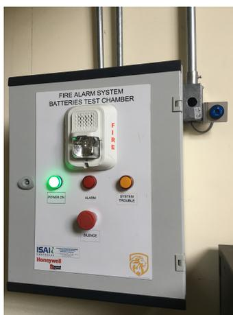
Figura 4.6: Tablero de incendio ubicado en la sala de ensayos de la Facultad de Ingeniería UDELAR. Hacia la derecha se observa un sensor de gases instalado en la pared junto a él.
