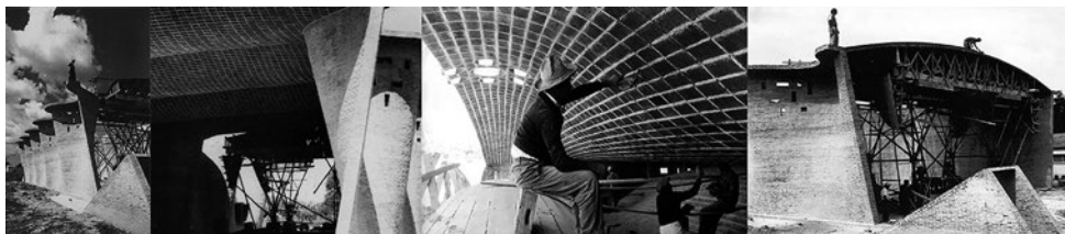
Figuras 06-09. «Cimbra para la construcción del techo». Foto Marcelo Sasson
