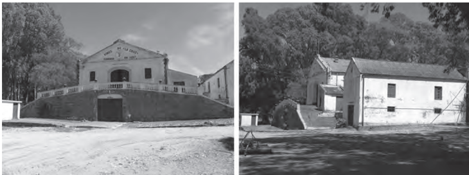
Figuras 5 y 6. Bodega La Cruz (frente y lateral derecho)
