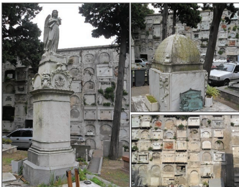
Figura 5. El ala E antes del derrumbe
