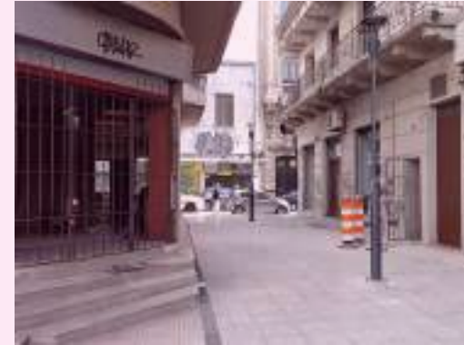
01. Las plantas bajas próximas se encuentran activas, gracias a locales gastronómicos abiertos o en obra.
