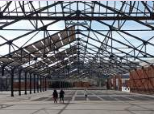
06. También se observa que la plaza es utilizada como espacio de atravesamiento, aportando a los trayectos circulatorios seguros del barrio.
