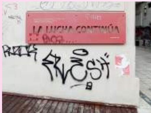
04. La cartelería se encuentra deteriorada y con grafitis, así como todos los muros de la plaza.
