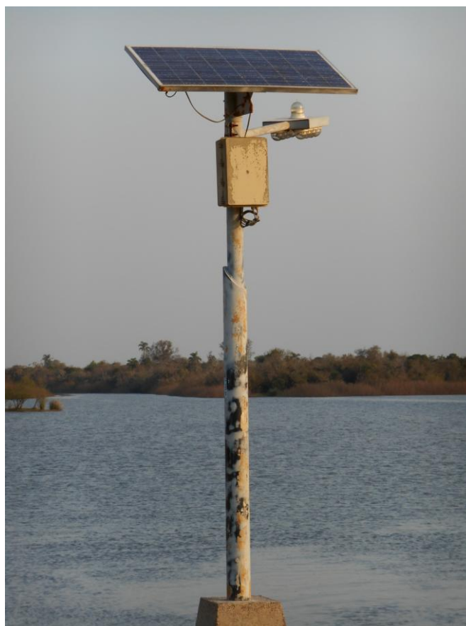
Imagen 5: Panel solar que alimenta una lámpara. Fotografía sacada en el puerto de Charqueada, Treinta y Tres. Agosto 2014
