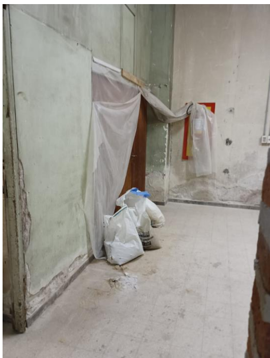
Figura F18. Entrada de emergencia, reforma del Archivo
