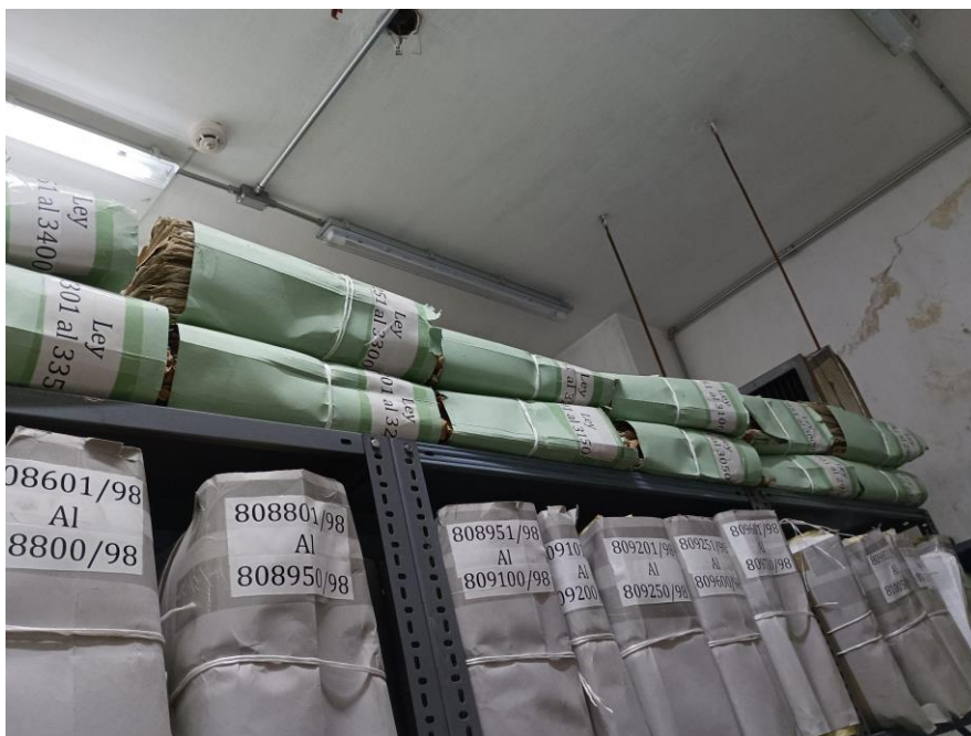
Figura F2. Condiciones del depósito, humedad en paredes
