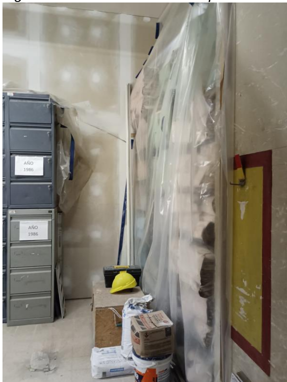
Figura F17. Más de la reforma que se está llevando a cabo
