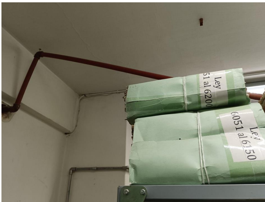
Figura F1. Cañería de PVC apoyada en los paquetes de la serie referida
