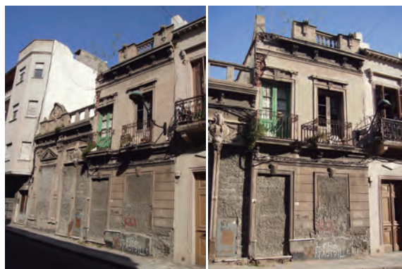
Figura 4.11 y 4.12 Inmuebles 5 y 6. Padrón 3622. Inmuebles vacantes relevados en 2018, ubicados frente por frente al inmueble 3. Fuente: Inventario del patrimonio arquitectónico y urbanístico de Ciudad Vieja 2010 y 2000.
