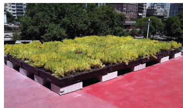
TERRAZA SEMI TERMINADA
