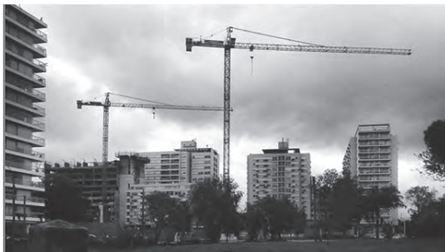
68. La Isla de Malvín en construcción, circa 2015. Fuente: fotografía del autor.
