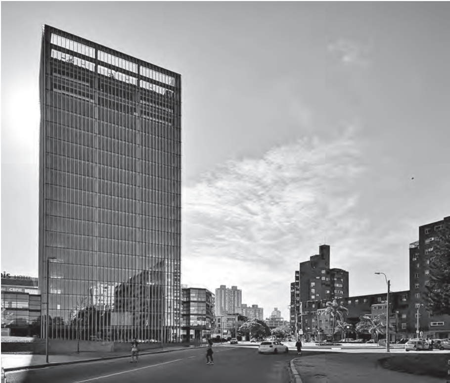
128. Encuentro fortuito de especies distintas de torres en la rambla sur. De izquierda a derecha, Torre Plaza Alemania, Estrellas del Sur y el Complejo CH100. Reflejados: bloques del conjunto Lamaro. Todos son casos excepcionales que recurren a la articulación urbana. Fuente: fotografía del autor.
