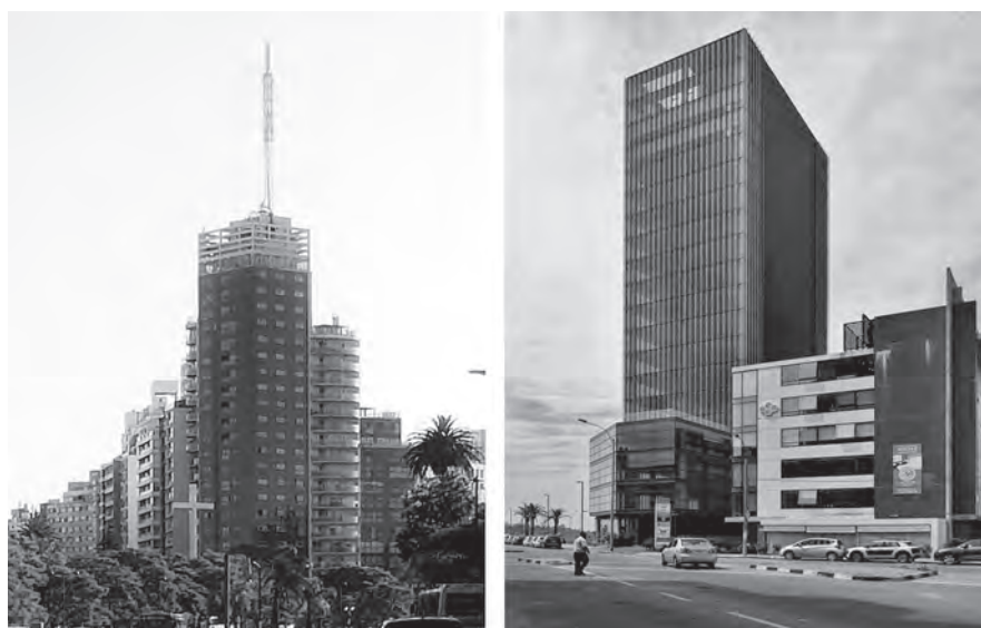
122. Articulación por adición: escalonamiento en Torre del Congreso y pequeños pies en la torre Plaza Alemania. Fuente: fotografía del autor.
