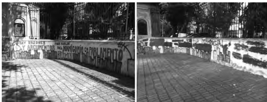
Figura 10. Foto de los muros atacados por parte de los funcionarios del hospital, octubre de 2015
