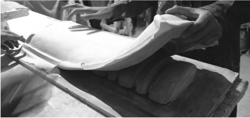
IMG 115. Molde de caucho siliconado de ornamento sobre dintel.
