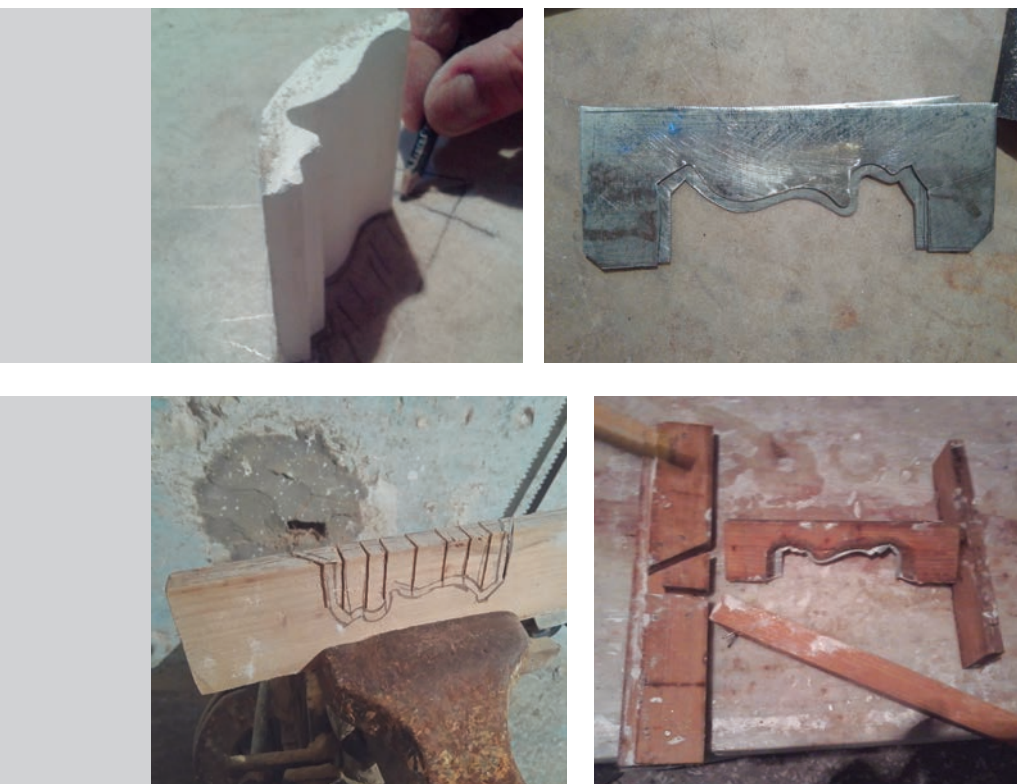
IMGS 84-87. Proceso de armado de carro con plantilla para moldura corrida.
