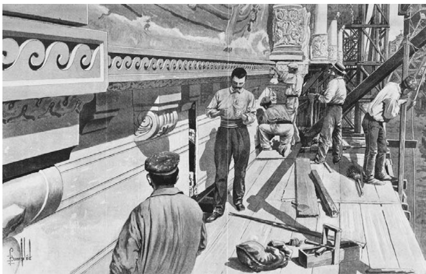
IMG 30. Equipo de artesanos realizando trabajos de ornamentación en fachada del Palacio de Ingeniería Civil y Medios de Transporte, Campos de Marte. Exposición Universal de París, 1900.
