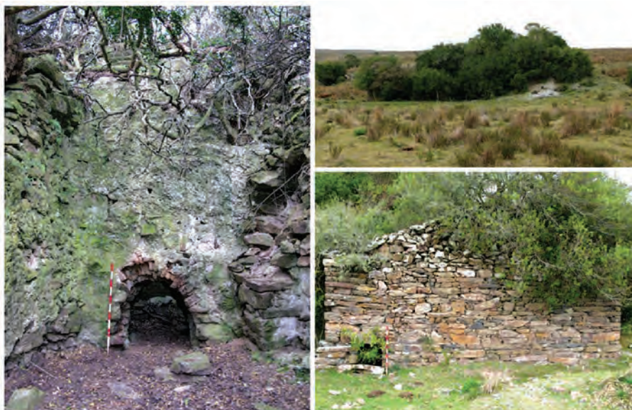
Vista general de fachada del horno (izquierda). Vista general de horno y rampa (derecha arriba) y detalle de muro de galpón con ducto de ventilación (derecha abajo).
