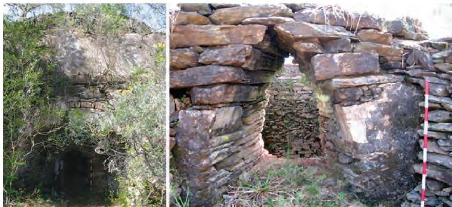
Vista general del horno (izquierda) y detalle exterior de abertura ubicada en el tramo del sector superior de la olla de calcinación (derecha).
