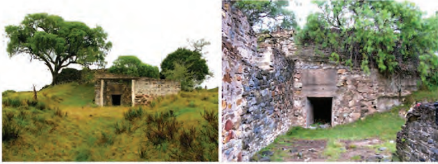
Vista general del horno (izquierda) y detalle de boca de descarga (derecha).
