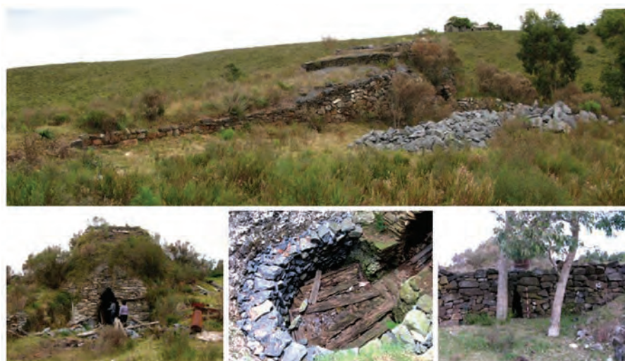
Vista lateral del horno (arriba). Fachada del horno, detalle de zapata y ducto de ventilación (de izquierda a derecha).
