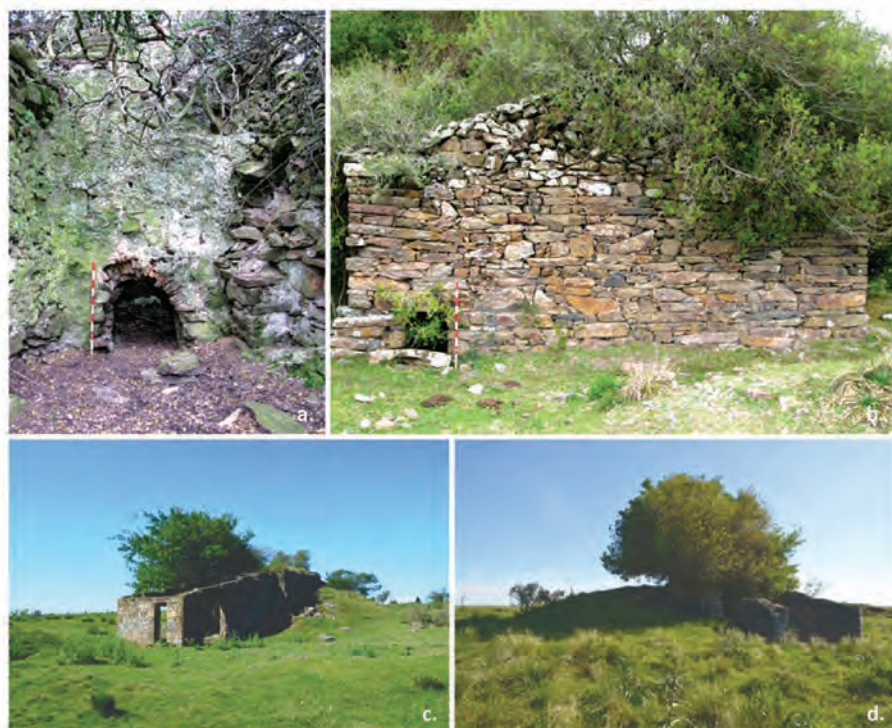
Figura 37. Galpones y muros adosados a los hornos de quema. a. Vista de horno desde interior del galpón (H15). b. Vista de muro de galpón con detalle del ducto de ventilación (H15). c. Vista general de galpón (H22). d. Vista general de muros laterales adosados a horno (H23). En ningún caso se conserva la techumbre.
