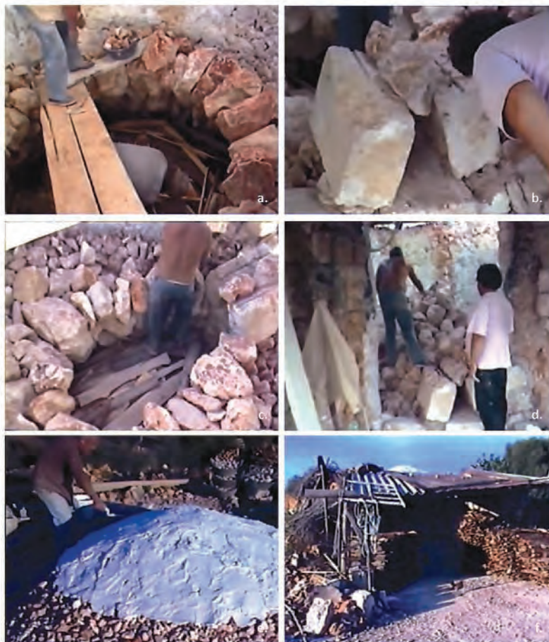
Figura 11. Armado del horno. a. Carga del horno con piedra y leña. b. Boca triangular base para construcción de la fachada principal. Se observan las marcas de barrenas en su superficie. c. Armado de cúpula dentro del horno. d. Vista de cúpula en construcción desde la fachada principal aún abierta. e. Sellado de cúpula superior. f. Vista general del horno listo para la quema. Se observa la cúpula sellada y el muro de la fachada principal concluido.
