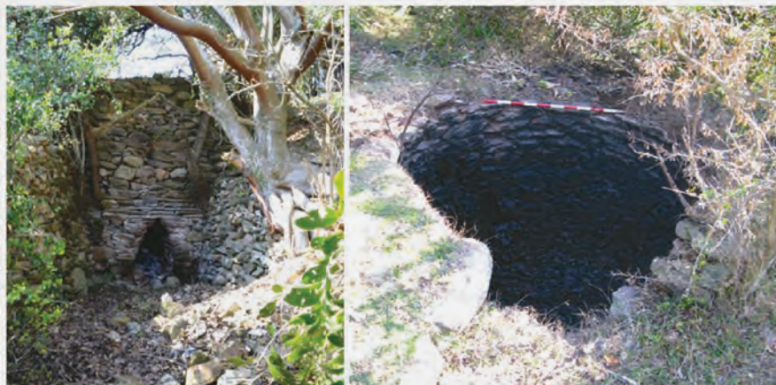
Vista general del horno y muros laterales (izquierda) y detalle de tramo superior de olla de calcinación (derecha).
