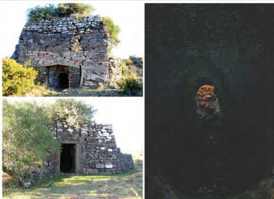
Vista general del horno y detalle de ventana en sector superior del horno (izquierda). Vista de la olla de calcinación, zapata y sobreboca desde la ventana ubicada en el sector superior (derecha).
