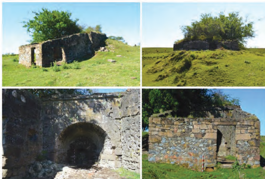
Vista lateral y posterior del horno (arriba). Detalle de fachada y de galpón con ducto de ventilación (abajo).
