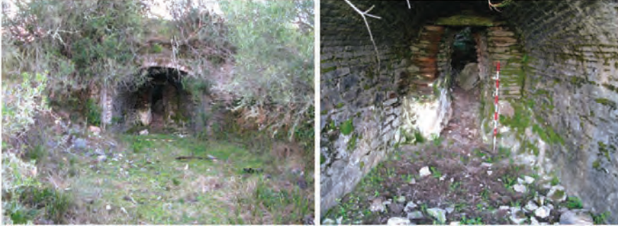
Vista general del horno (izquierda) y detalle de boca de carga (derecha).
