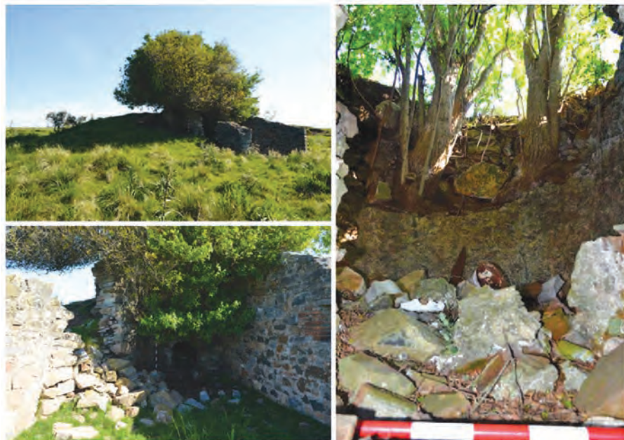
Vista general del horno (izquierda arriba), detalle de fachada (izquierda abajo) y detalle de olla de calcinación desde la boca de carga (derecha).
