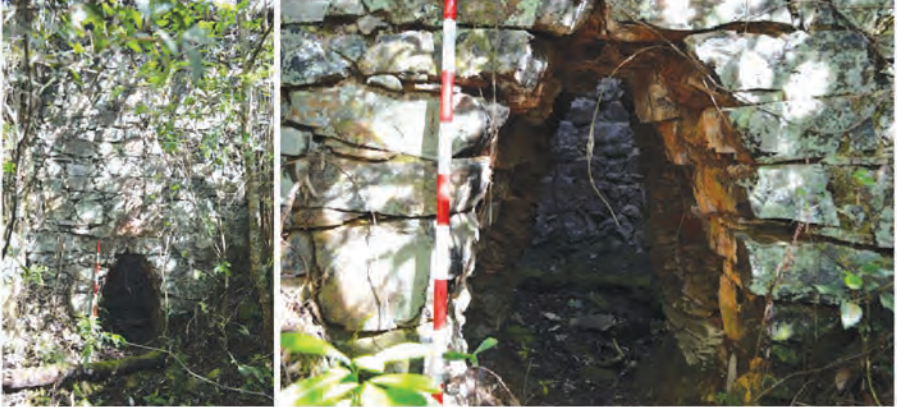
Vista general del horno (izquierda) y detalle de boca de carga con zapata al interior de la olla de calcinación (derecha).
