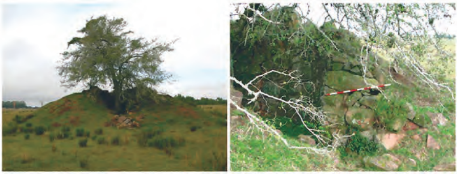
Vista general del horno (izquierda) y detalle del muro (derecha).
