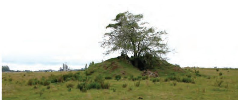
Figura 21. Vista general del horno Ho2 en planicie. Se observa un árbol nacido en la base de la olla de calcinación y recubrimiento exterior.
