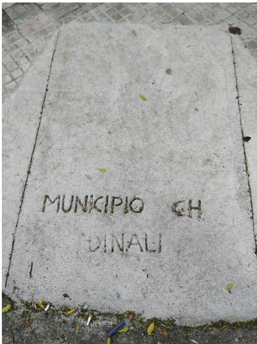
Rampa realizada en el Municipio CH. Foto: Nicolás Opazo
