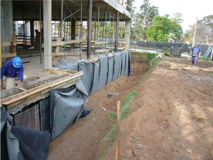
Colocación del geodren (plástico color negro) y a continuación el manto de geotextil (gris), el cual queda en contacto con la tierra. Se sostiene este sistema con un entablado sujetado a la estructura, hasta la colocación de los rellenos correspondientes.
