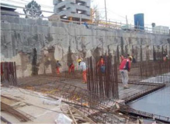
En esta imagen se puede apreciar la construcción del muro de hormigón colado a la vista, en la que aun no se ha ejecutado la regularización de la superficie y la construcción de la cámara de aire según detalle precedente.
