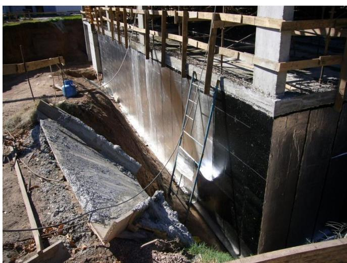
Aplicación de membrana asfáltica con terminación de aluminio.
