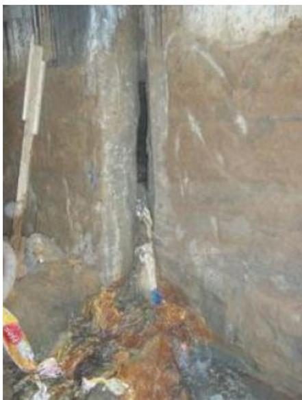
En esta imagen se puede ver que al no soportar el muro de contención la presión de la napa freática (que no se tuvo en cuenta), se generaron grietas del orden de entre 5 y 10 cms.
