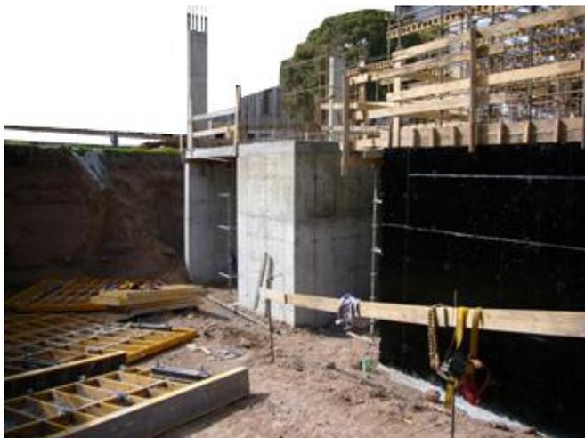
Luego del fraguado del hormigón de los muros de contención, se comienza el proceso de desencofrado.
