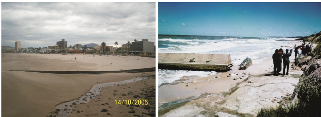
Figura N°20.: Izq: Playas de Piriápolis (Maldonado) donde se implantaron espigones para evitar pérdidas de la playa. Der: Espigones en La Floresta (Canelones) donde ha habido un muy notorio retroceso de la línea de barrancas fruto de la erosión, y las cabeceras de los espigones por esa causa se encuentran separadas.
