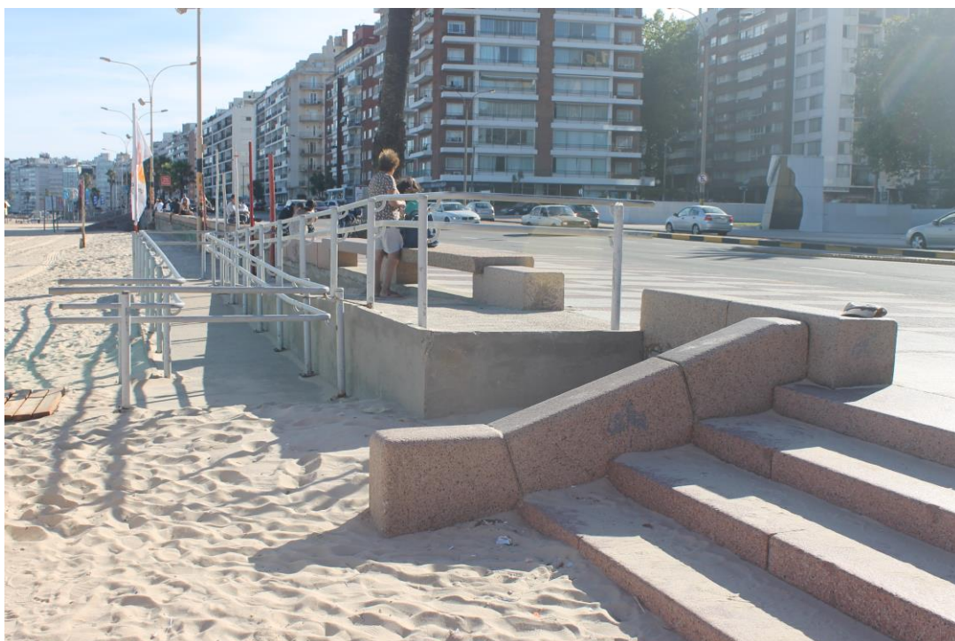
Figura N°37. Vista general de la rampa de acceso en Playa Pocitos desde la arena.
