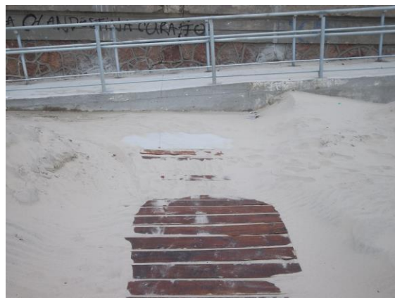
Figura N°44. Detalle del inicio de la pasarela, de Playa Ramírez
