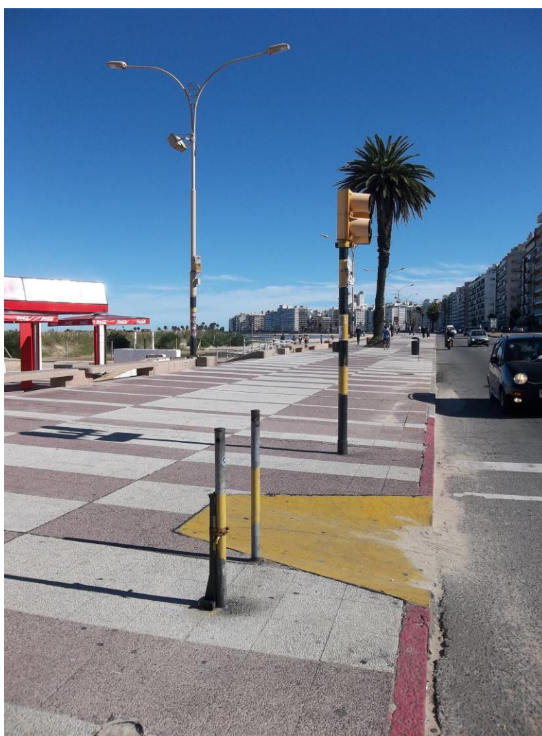
Figura N°29. Inexistencia parada de ómnibus en rambla de Playa Pocitos.
