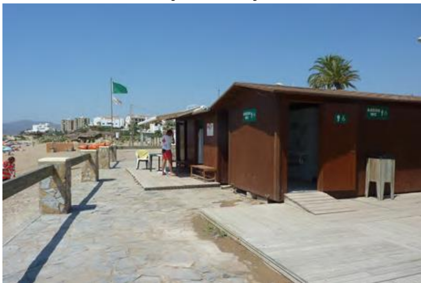
Figura Nº15. Acceso a baños adaptados.
