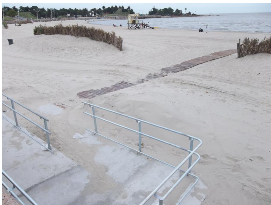
Figura N°47. Vista aérea del contacto entre la rampa y la pasarela en la Playa Ramírez.
