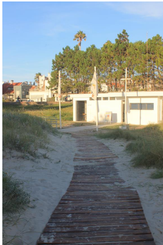
Figura N°66. Edificación destinada a baños y servicios médicos.
