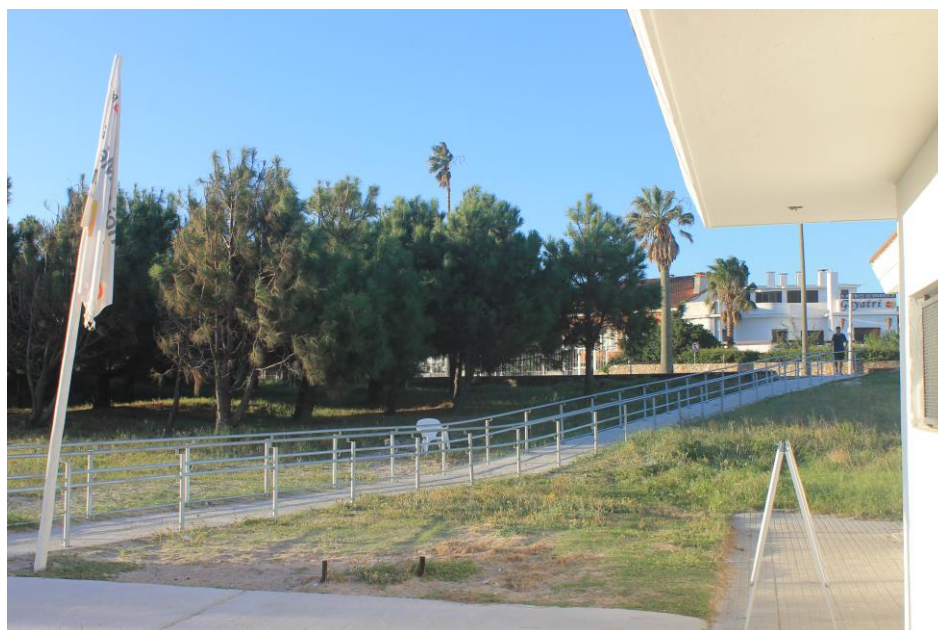
Figura N°42. Vista longitudinal de la rampa de acceso en Playa Verde.
