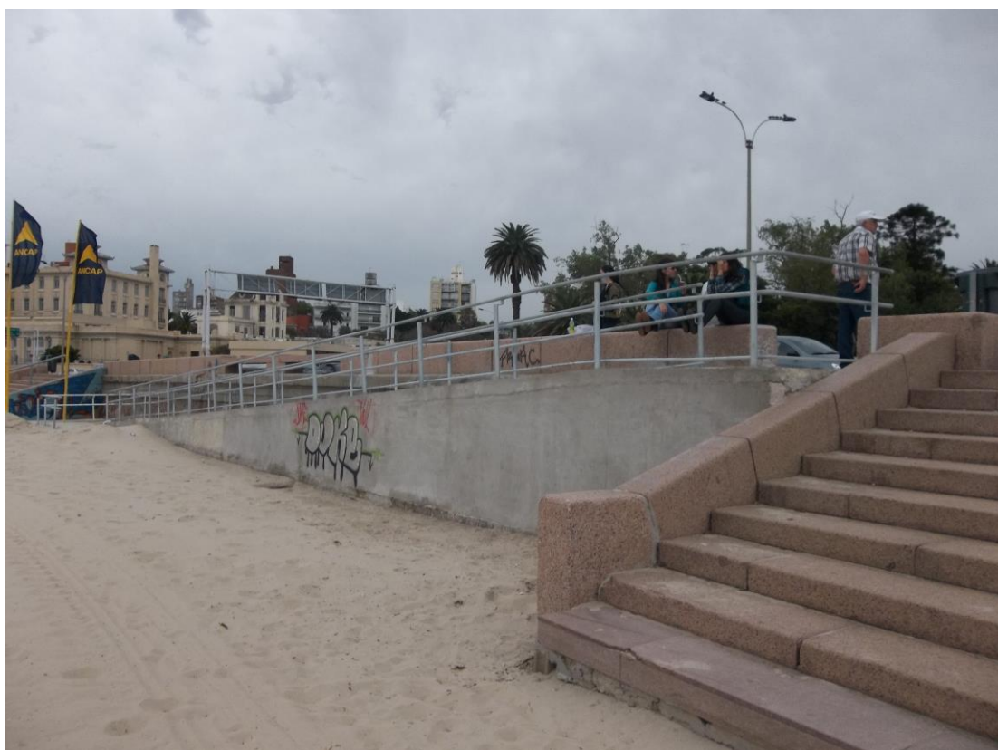
Figura N°34. Vista general de la rampa de acceso en Playa Ramírez.
