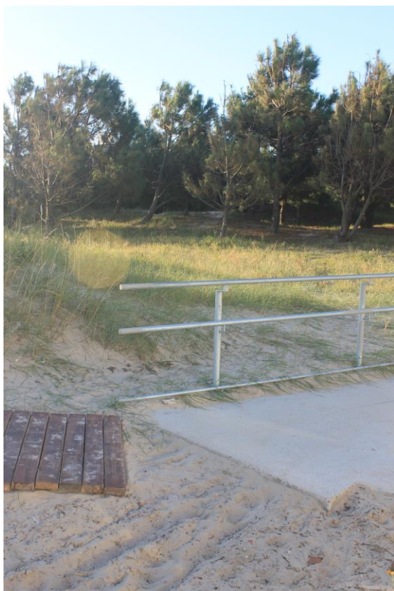
Figura N°61. Detalle del inicio de la pasarela en Playa Verde.
