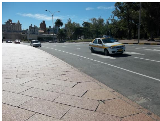
Figura N°25. Inexistencia de zonas de aparcamiento para personas con discapacidad sobre la rambla de Playa Ramírez.
