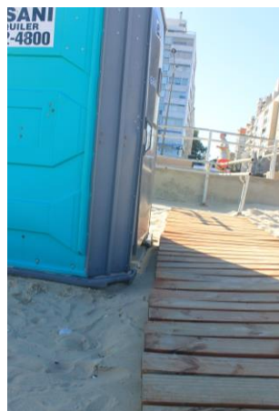
Figura N°54. Vinculación del módulo de baño con la pasarela en Playa Pocitos.
