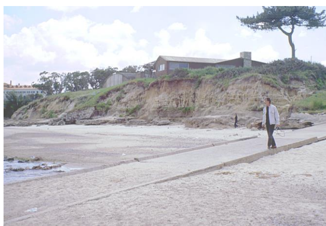
Figura N°21: La rampa para embarcaciones interrumpe el tránsito de arena, lo cual demuestra que las pasarelas sobre la arena no pueden ser de materiales pesados. Foto: Proximidades de Balneario Solís, Maldonado.
