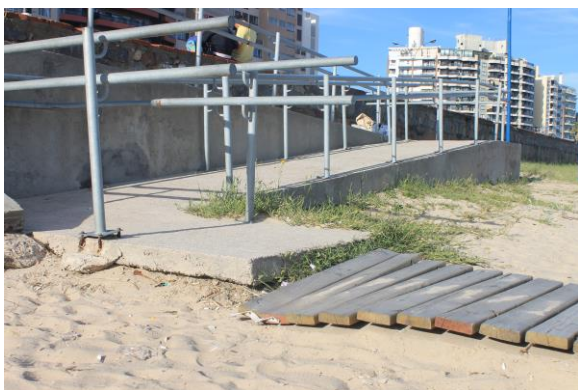
Figura N°55. Detalle del inicio de la pasarela en Playa Malvin.
