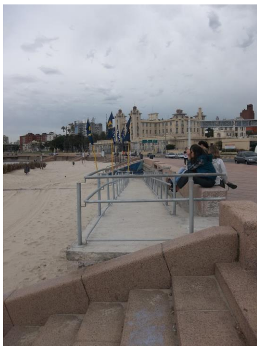
Figura N°35. Vista transversal de la rampa de acceso en Playa Ramírez.
