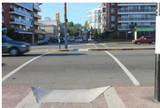
Figura N°31. Vados peatonales en rambla de Playa Malvin
