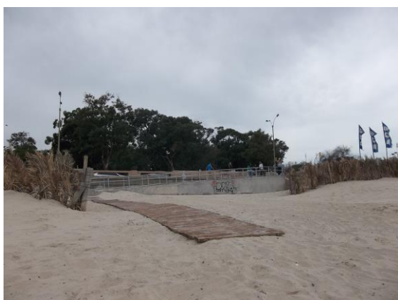
Figura N°45. Fin de la pasarela de Playa Ramírez.
