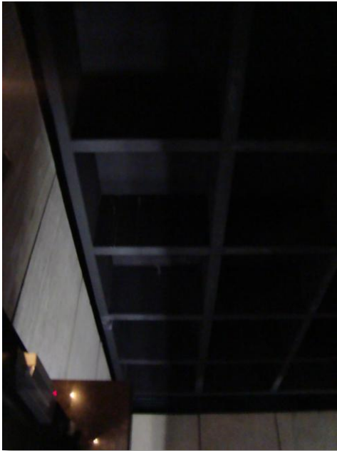
Imagen del encasetonado con la iluminación existente
