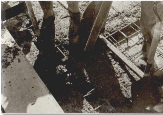
Vibrado de un cruce de vigas
