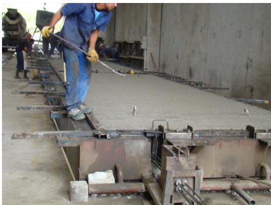
Sacando los agarres para la manipulación y traslado del panel, después del vertido de hormigón
