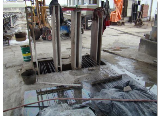
Anclajes donde se tesan los cables de las losas con un gato hidráulico
