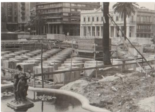
Colocación de casetones formando un damero
