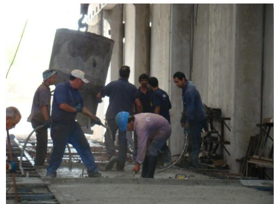
Vertido del hormigón en un molde
