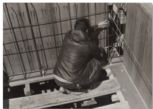
Armado de vigas
