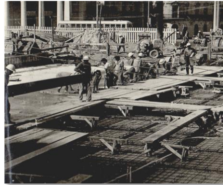
Llenado y recubrimiento de la superficie con antisol
