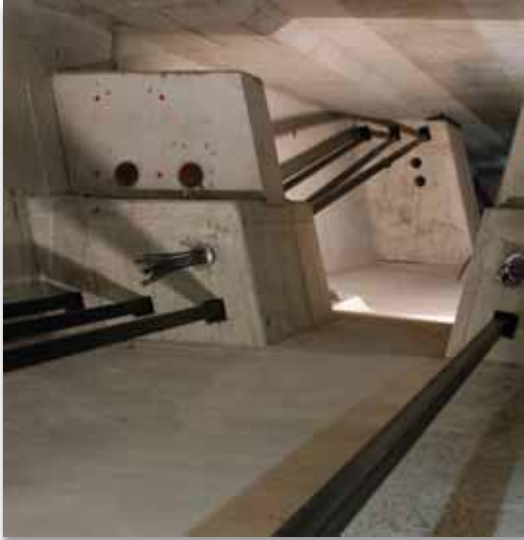
Cables de postesado en puentes
