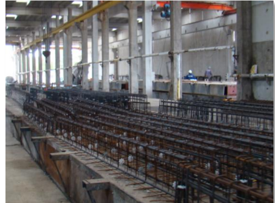
Recorrido de las cañerías de vapor que luego se entierran por debajo de cada molde
