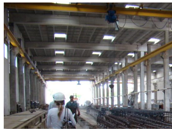
Paneles Pi colocados en la cubierta de la planta de producción de Flasur, donde se pueden apreciar sus lucernarios
