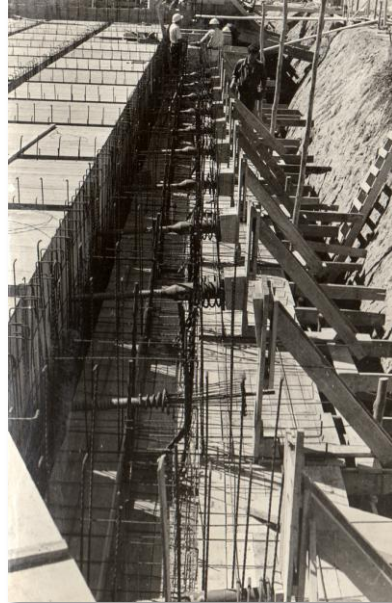
Puesta definitiva de las cabezas de anclaje
