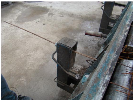
Anclaje del molde que tiene enterrado un bloque de concreto que lo hace capaz de soportar el total de la fuerza del pretensado durante el vertido y curado del hormigón hasta cortar los torones
