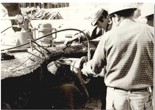
Puesta en tensión del sistema bbrv
