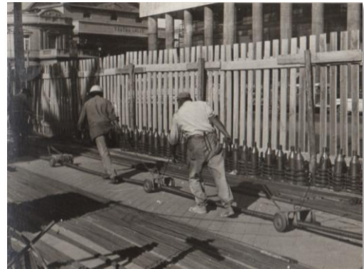
Sistema de carritos para el enhebrado de cables en las vainas
