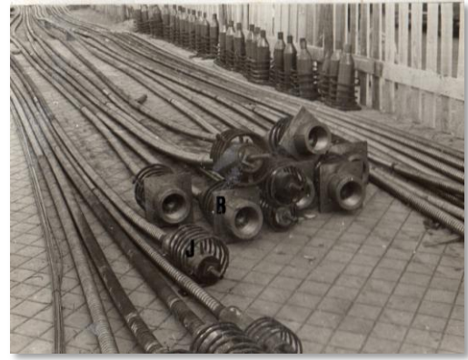
Anclajes móviles tipo J y tipo B
