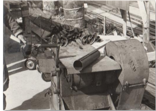
Máquina remachadora y pieza de unión de vainas
