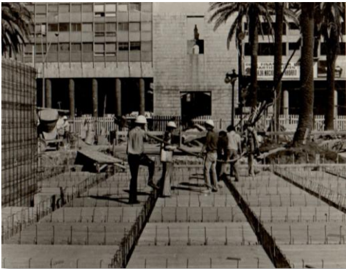
Colocación del sistema bbrv
