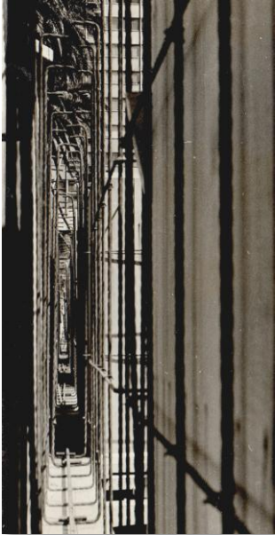
Vista de la viga libre de cruces de hierros longitudinales de las vigas ortogonales.
