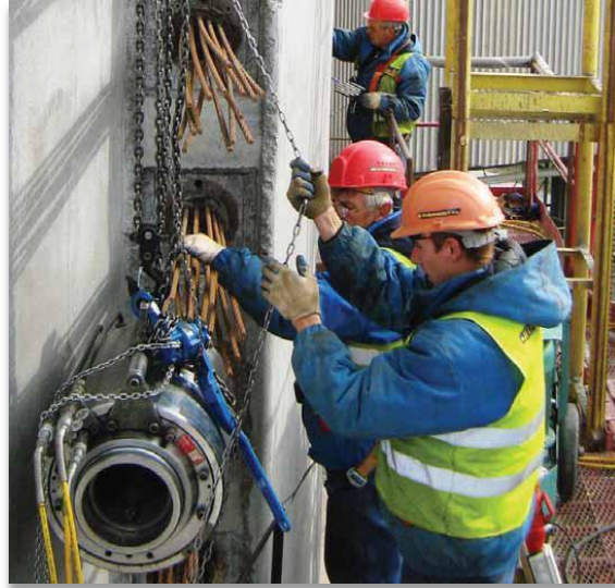
Ejecución de postesado en obra de ingeniería
