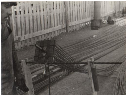
Anclaje fijo tipo S enhebrado
