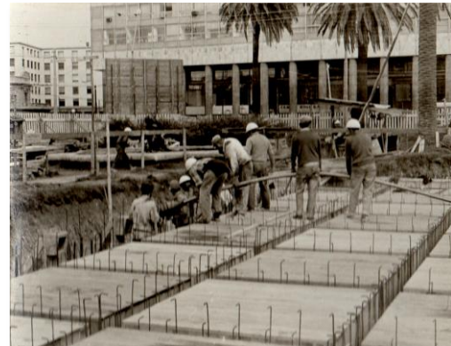
Colocación del sistema bbrv
