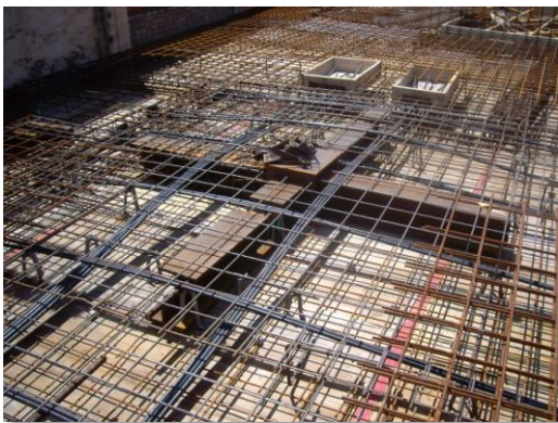
Instalación de Cables en losa postesada
