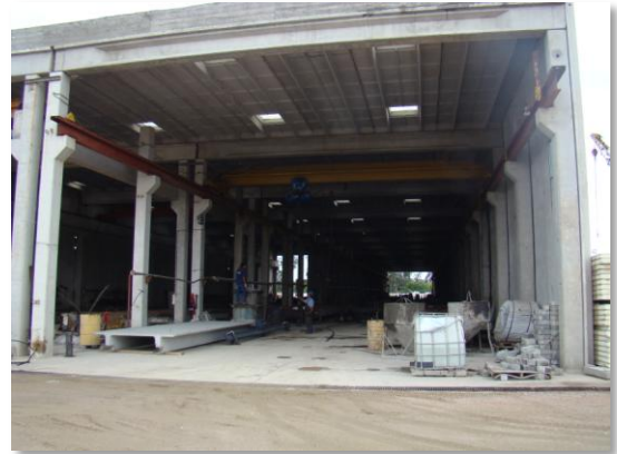
Área de producción techada de Flasur, realizada en su totalidad con un sistema prefabricado pretensado de vigas y paneles
