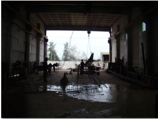
Sector de herrería en la planta de producción de Flasur
