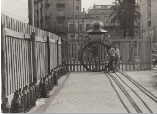
Tendido de cables
