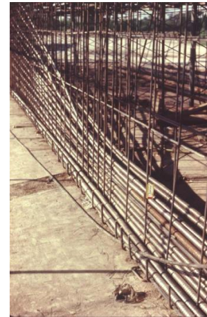
Colocación de ductos en viga postesada
