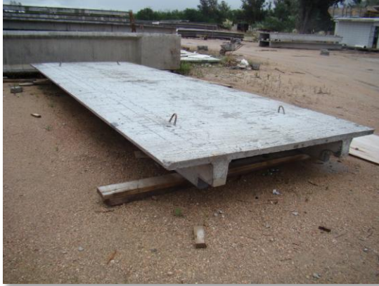
Panel doble T pronto con sus agarres para su manipulación y traslado
