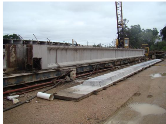
Viga I en su molde desarmado
