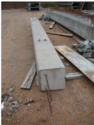
Viga rectangular con agarres y hierros de unión previstos
