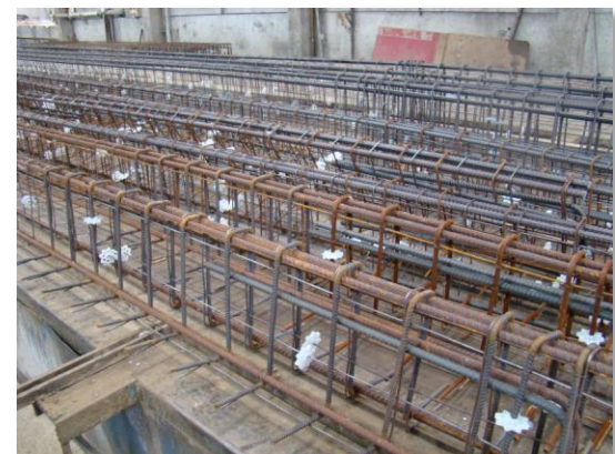
Armaduras prontas en el sector de herrería
