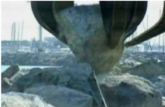
Construcción del rompeolas
