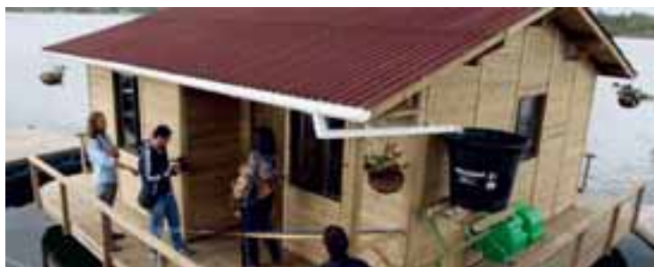
CONSTRUCCIÓN CASA FLOTANTE COLOMBIA
