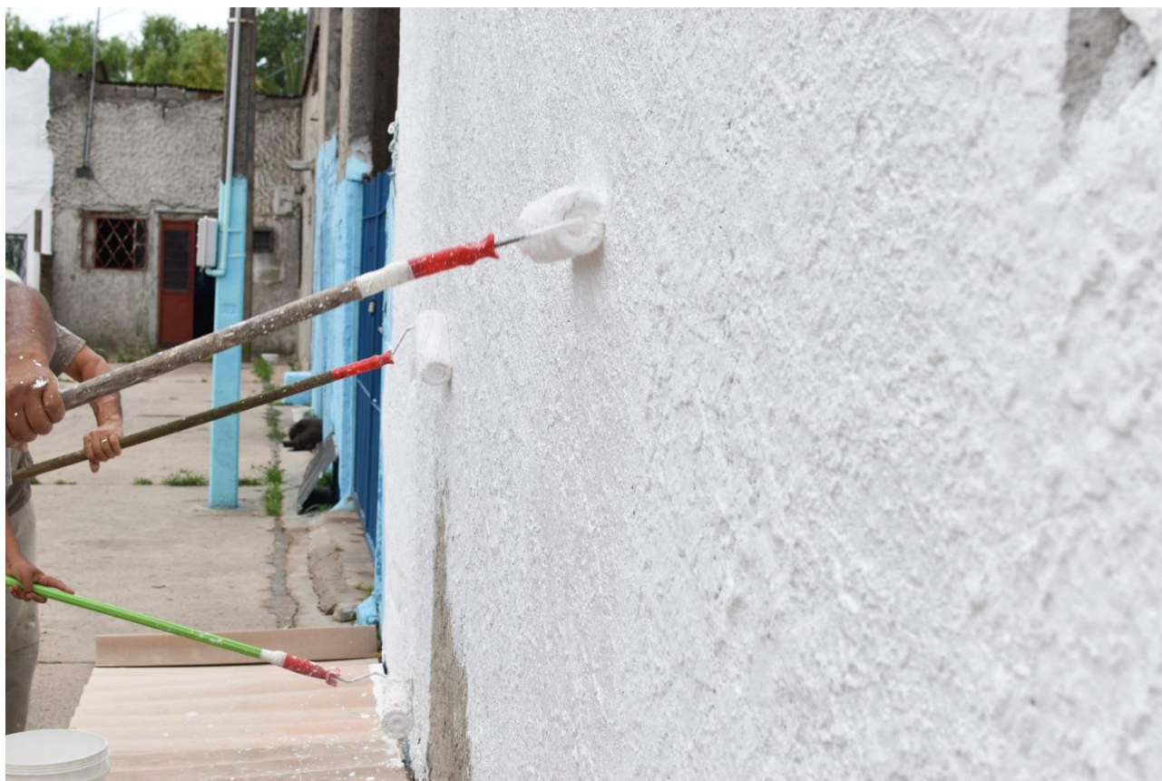
Figura 15: Comienzo de intervención en muro de la ex fábrica Berlain. Noviembre del año 2022.
