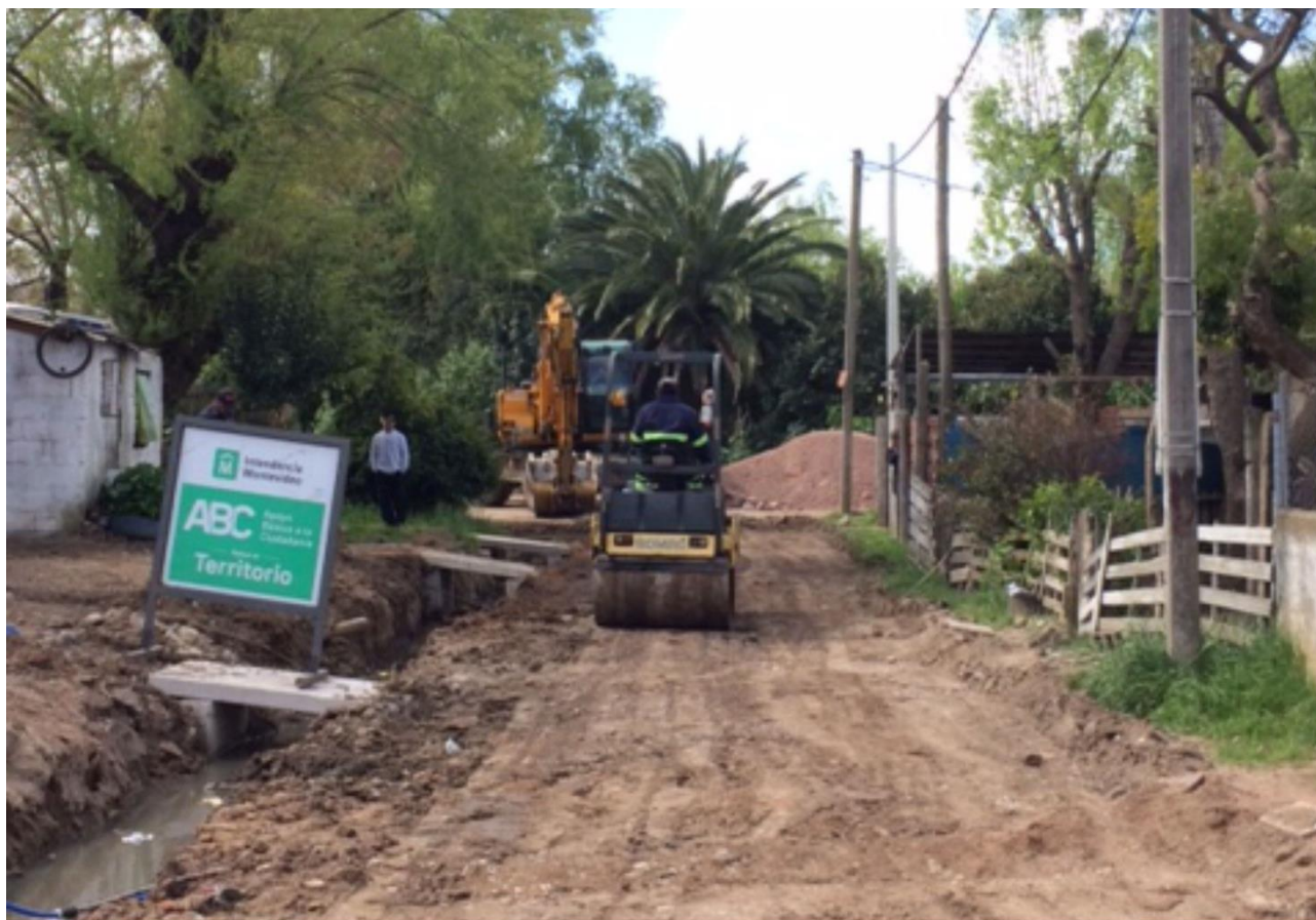
Figura 19. Arreglo de pasajes y generación de cunetas. Tarea realizada por el Plan ABC de la IM.
