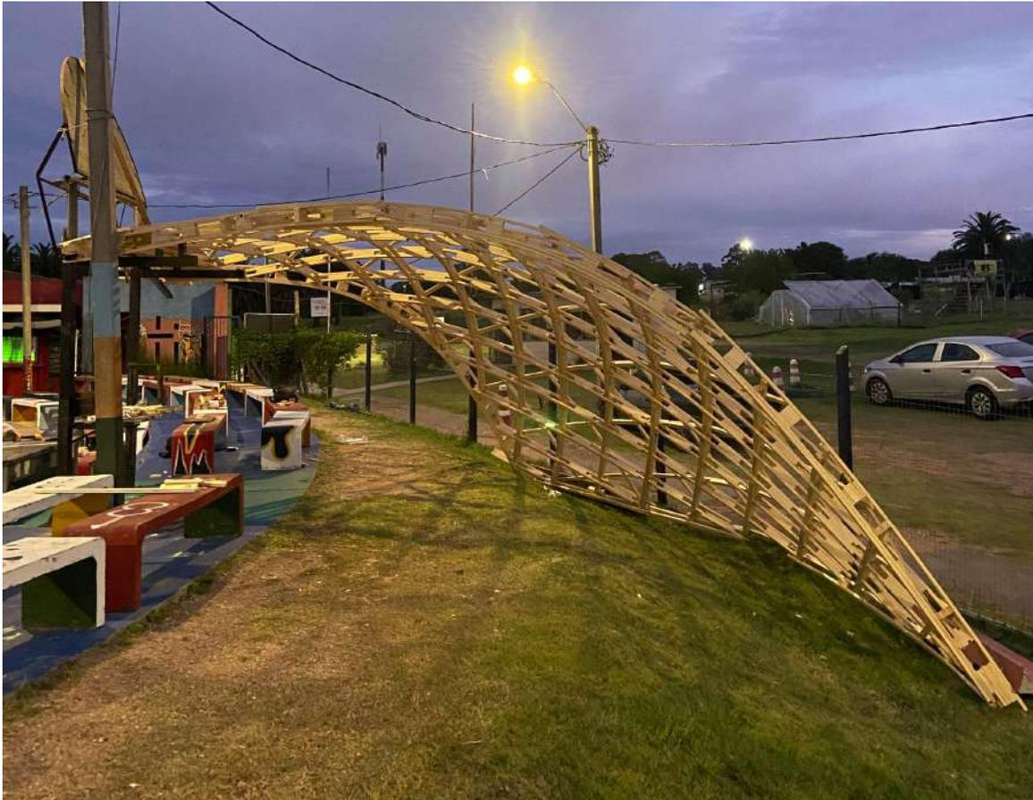
Fig. 19 y 20 fotos superiores, montaje de la segunda y tercer capa por estudiantes del Diploma en Madera. Foto Adriana Goñi
