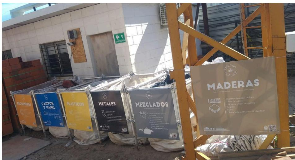
**Figura 4.1.2.1** Fotografía de bolsones para clasificación de fracciones de residuos en obra. Fuente: ReAcción
