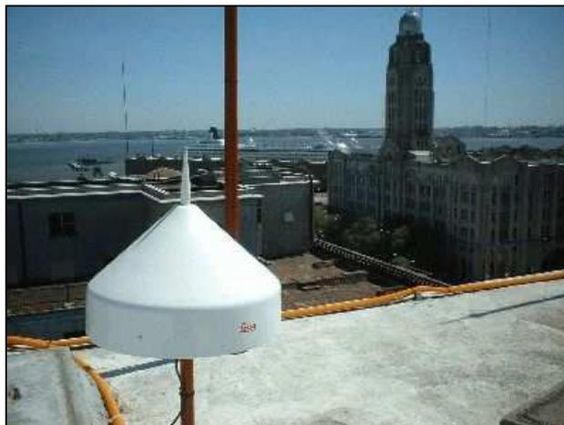
*Fig 9.17: Estación de referencia DGPS en edificio de ANP*
