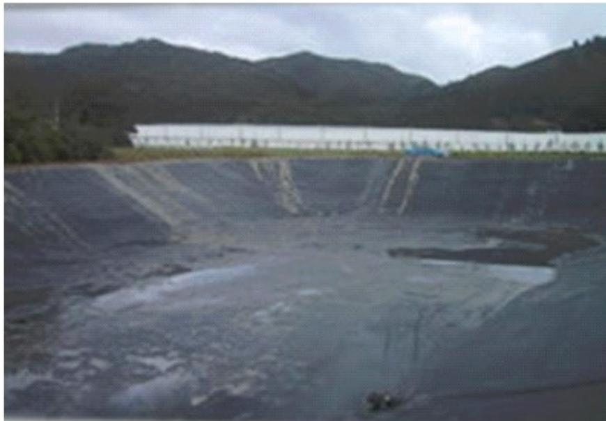
*Figura 55: Membrana de impermeabilización.*
