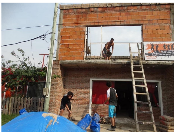
Figura 5: Fotografía de la construcción de la sede
