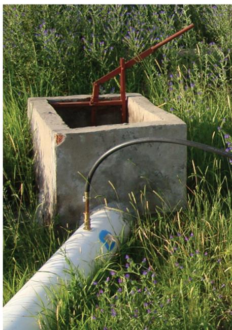
Figura 2. Compuerta y tubo de alimentación con Pitot instalado.
