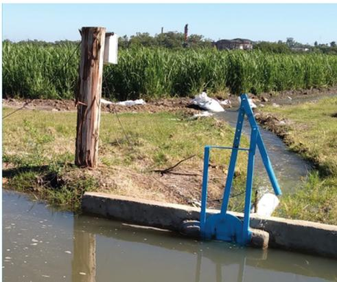
**Figura 12.** Pitot inserto en tubería aguas abajo de una compuerta en riego por canales en caña de azúcar.
