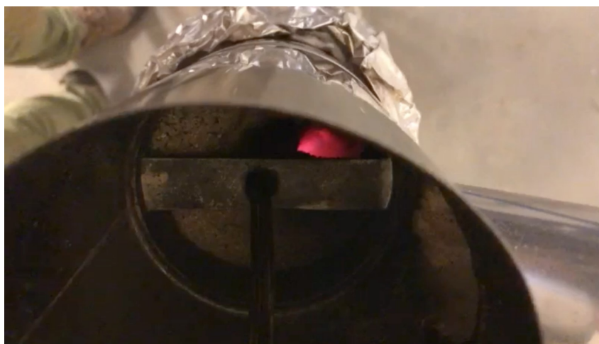
Figura 6.6: Hueco producido a causa del colapso de la mezcla en experiencia 1
