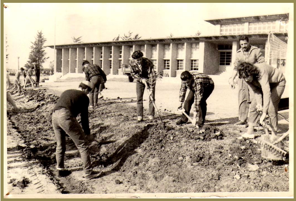
Ilustración 2 Estudiantes y jóvenes del barrio construyendo el piso de la cancha de voleibol
