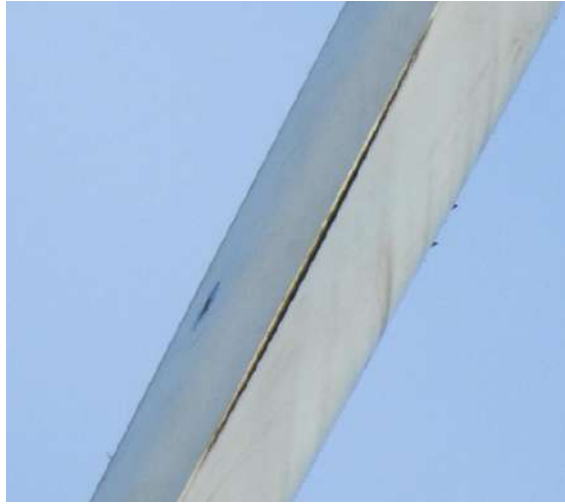
(a) Pala con crack real.
