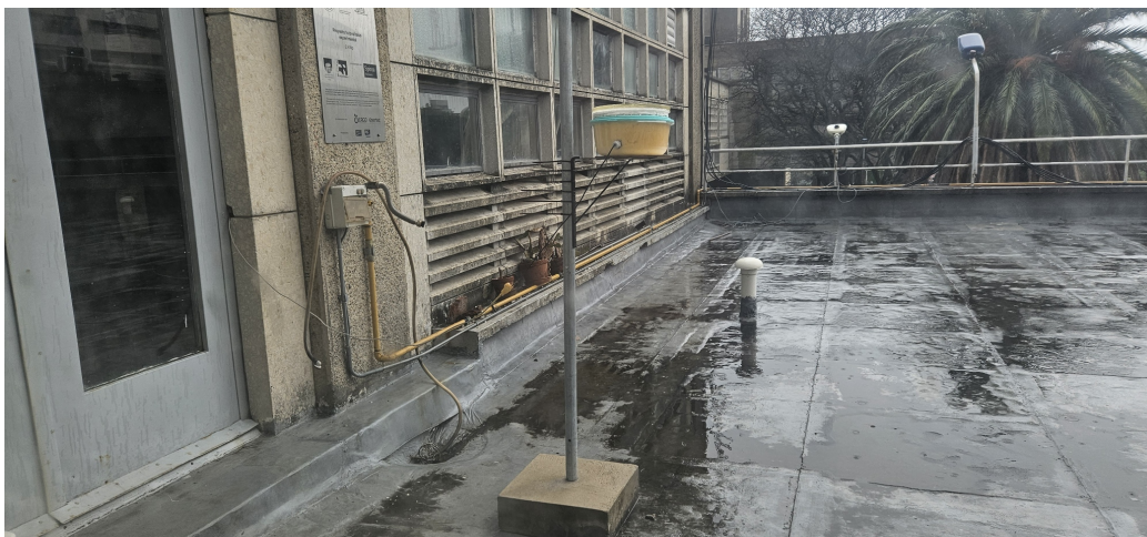
Figura 7.2: Prototipo del sensor de granizo instalado en exteriores, en la terraza del Instituto de Ingeniería Eléctrica, FIng - UdelaR.
