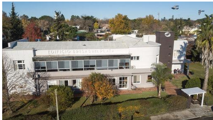
Figura 2.1: Edificio del Residencial Brisas del Plata
