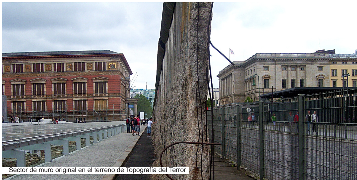
Terreno de Topografía del Terror antes de la construcción del Centro de Exposición, 2009
