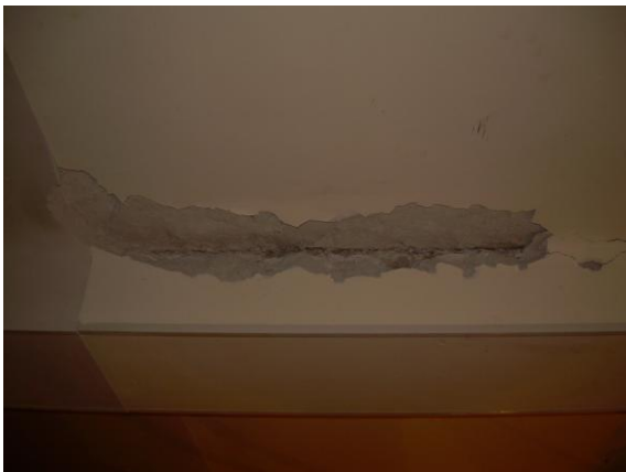
IMAGEN 5:11 VIGA DAÑADA POR LA EXPLOSIÓN
