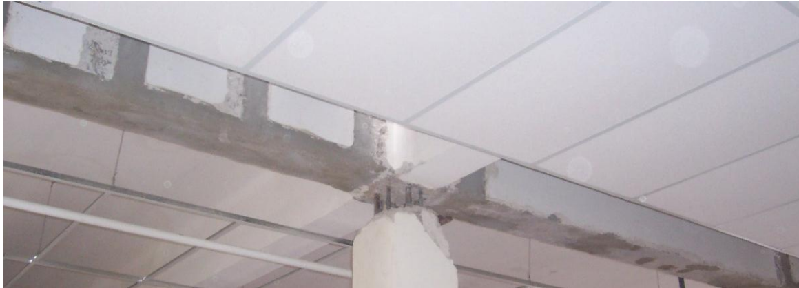
IMAGEN 5:4 VIGA SEMI INVERTIDA CON TENSOR – PICADO DE REVOQUES EN ZONAS DE APLICACIÓN DEL REFUERZO
