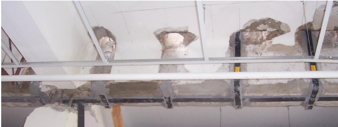
IMAGEN 5:9 VIGA SEMI INVERTIDA CON TENSOR – PICADO DE LOSA PARA ATRAVESAMIENTO DE SIKA CARBO SHEAR L
