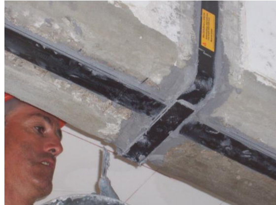
IMAGEN 5:9 VIGA SEMI INVERTIDA CON TENSOR – PICADO DE LOSA PARA ATRAVESAMIENTO DE SIKA CARBO SHEAR L
