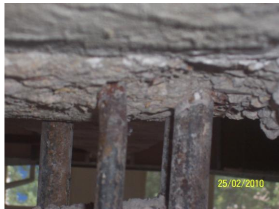
IMAGEN 5:6 VIGA SEMI INVERTIDA CON TENSOR – PICADO DE HORMIGÓN PARA ATRAVESAMIENTO DE REFUERZOS
