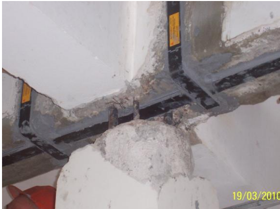
IMAGEN 5:9 VIGA SEMI INVERTIDA CON TENSOR – PICADO DE LOSA PARA ATRAVESAMIENTO DE SIKA CARBO SHEAR L
