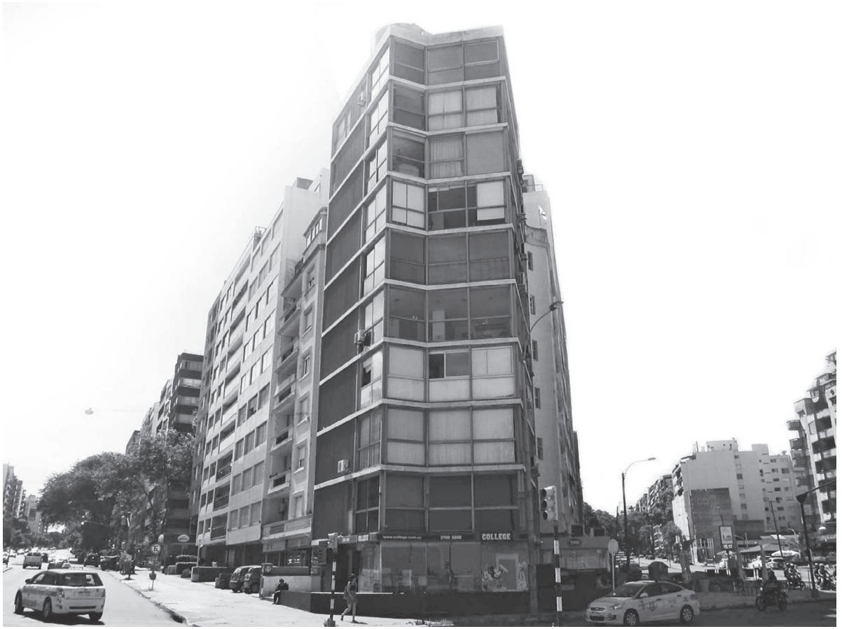
Figura 1. Vista del edificio El Pilar desde Rambla República del Perú. Imagen del autor.
